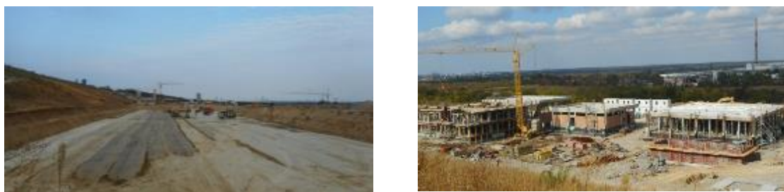
Figura 2: Costruzione dell'impianto di smaltimento nazionale foto SERAW
