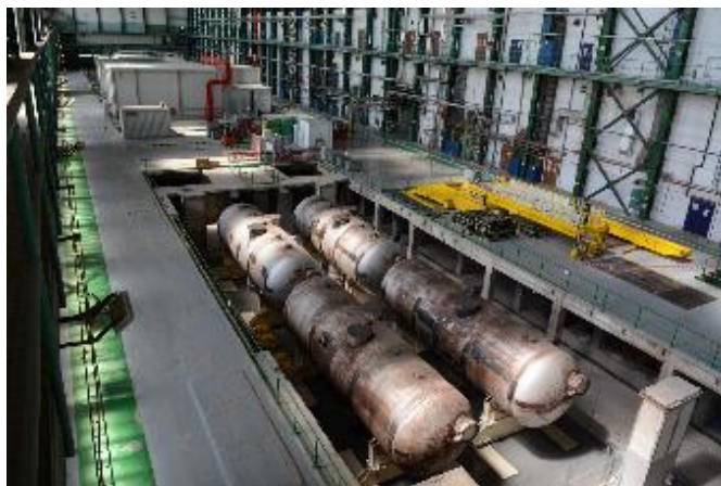
Figura 5: Officina e deposito dei generatori di vapore nella ex sala turbine foto JAVYS
