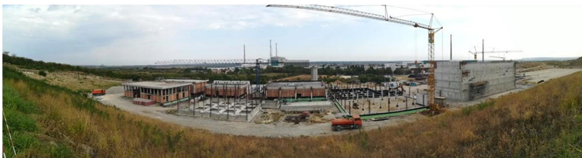
Figura 2: visione d'insieme della costruzione dell'impianto di smaltimento nazionale foto SERAW
