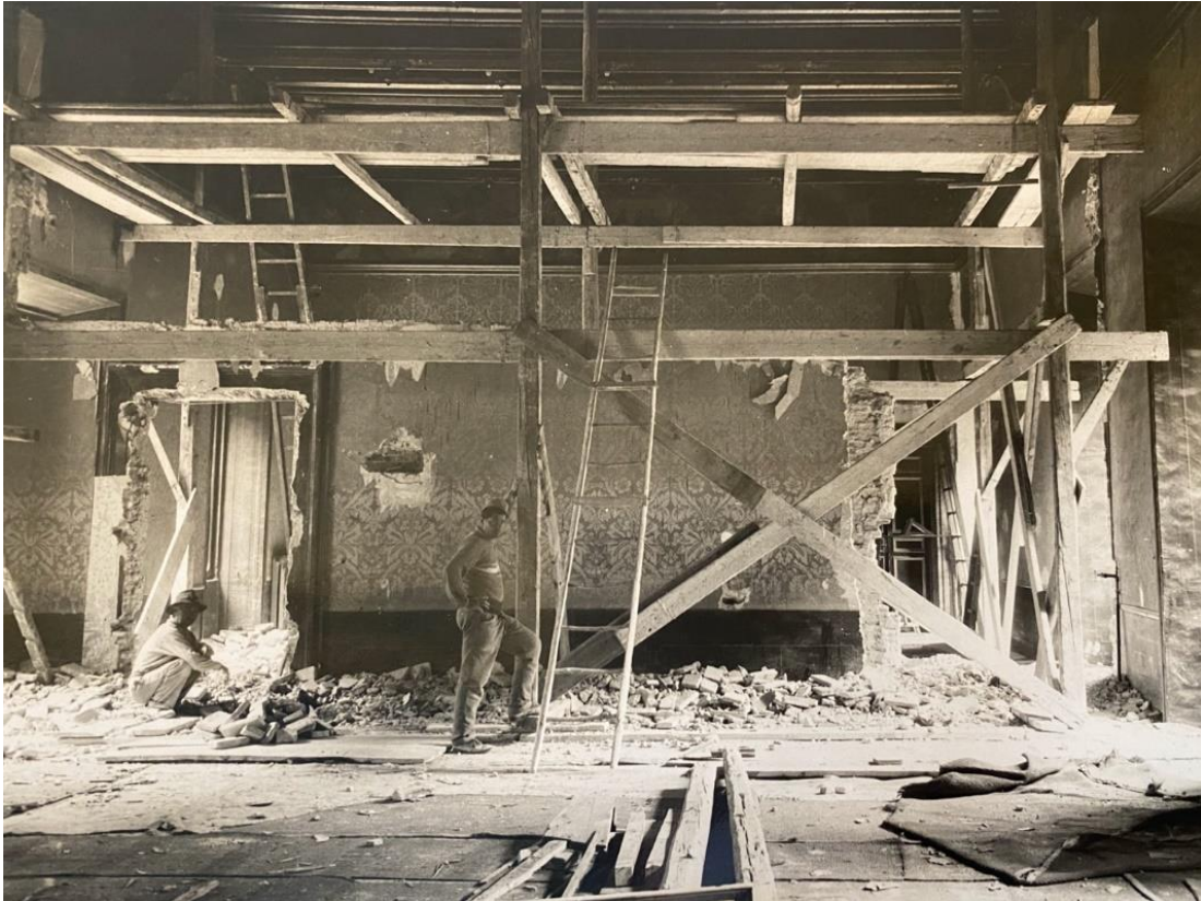
Fotografia del Salone dei Re durante i lavori in corso, ca. 1925
