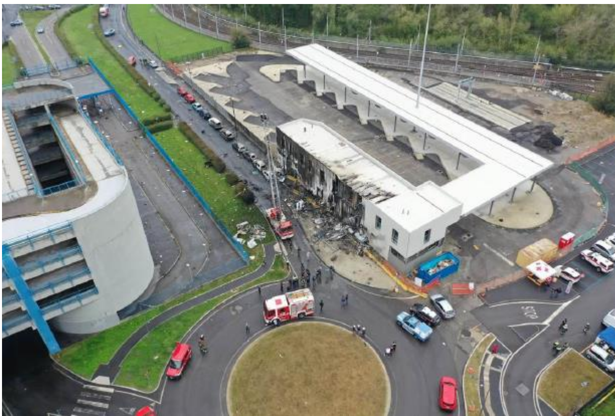
Ripresa aerea effettuata dell'area dell'incidente.
