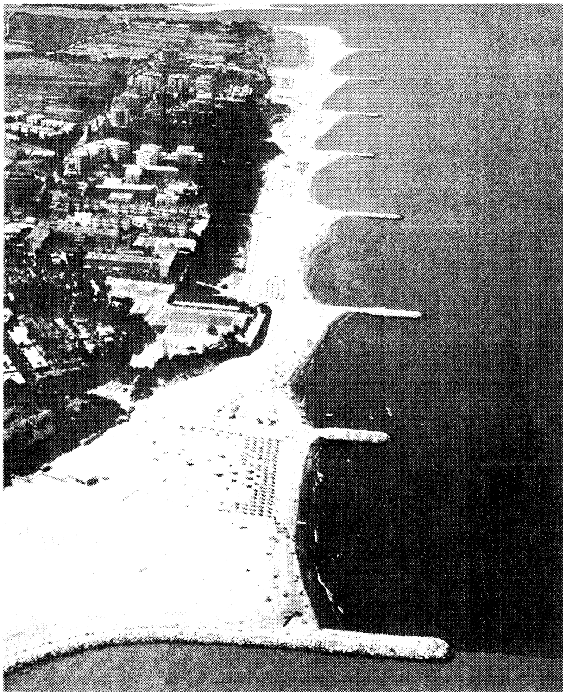
Il litorale di Isola verde al termine dei lavori
