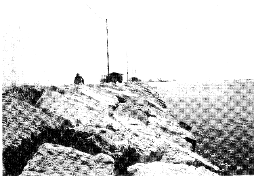
Il molo di Malamocco nord durante i lavori
