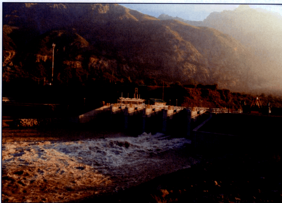
ASTALDI CONCESSIONI S.r.l. Cite
