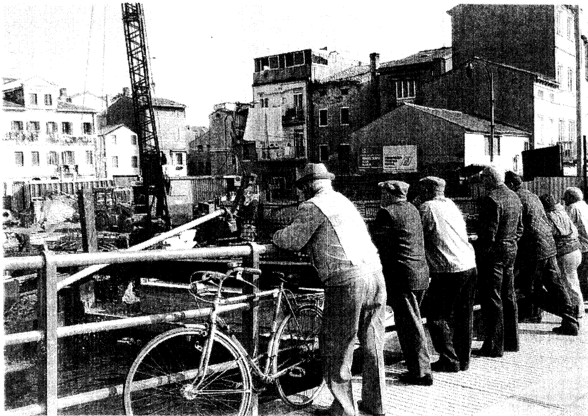
Difesa locale dalle acque alte
