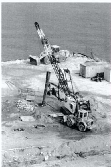
Bocca di Lido - Campo prova dei pali di fondazione. Fasi di lavoro
