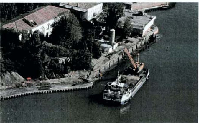
Isola di Poveglia. Fase dei lavori di ripristino delle rive
