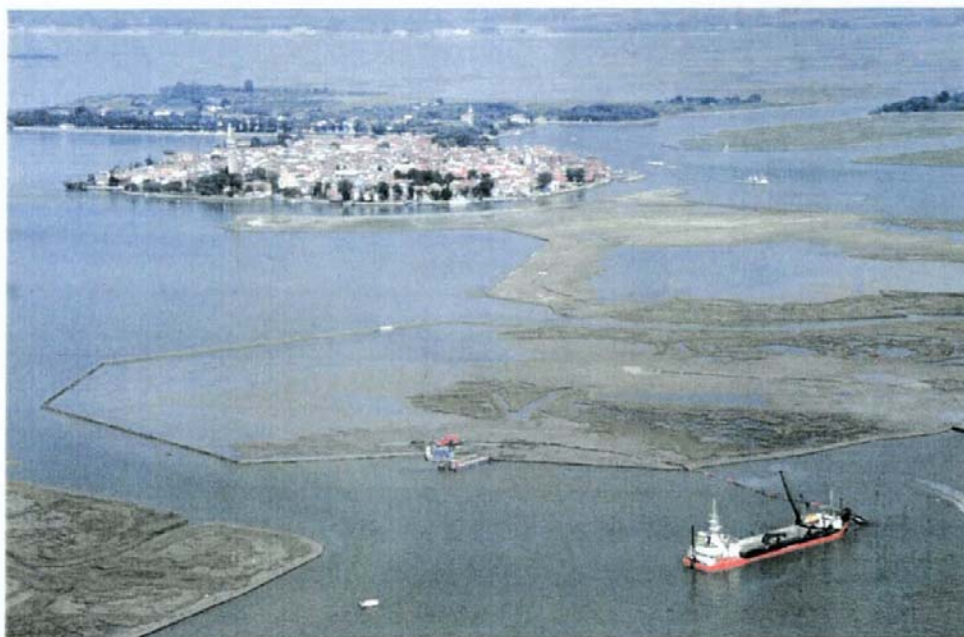
Burano. Situazione della barena durante i lavori
