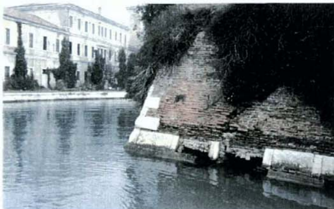
Isola di Poveglia. Un tratto della riva prima dei lavori
