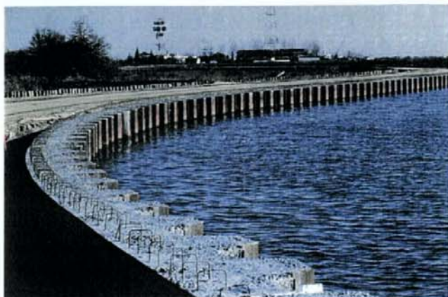
Barena del Passo a Campalto. Un tratto del palancolato metallico che delimita il bordo dell'area lungo la laguna
