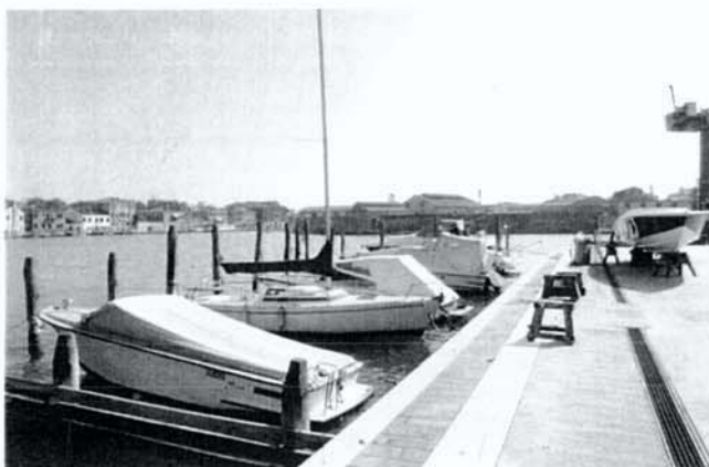
Murano - Canale degli Angeli. La riva dopo i lavori
