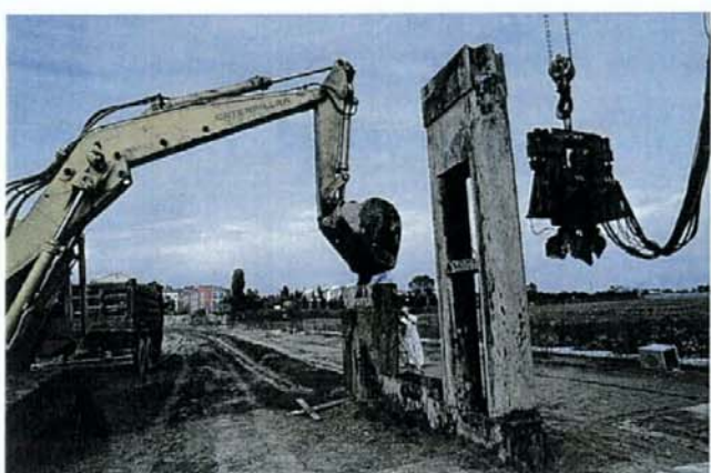
Barena del Passo a Campalto. Realizzazione del diagramma di bentonite granulare (area fosfogessi). Riempimento del cassero della benna
