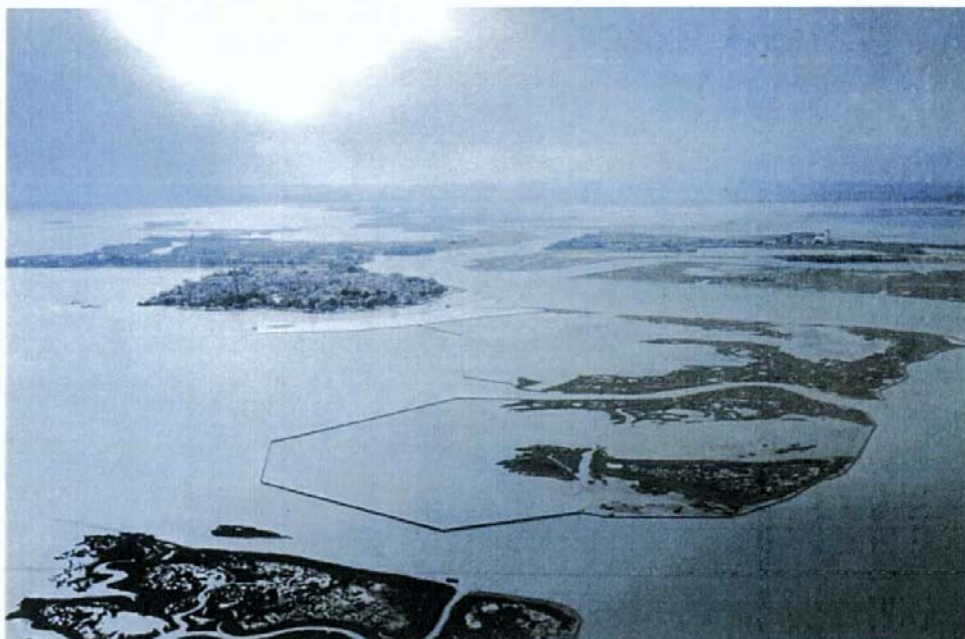
Burano. Situazione barena a ridosso dell'isola prima dell'intervento
