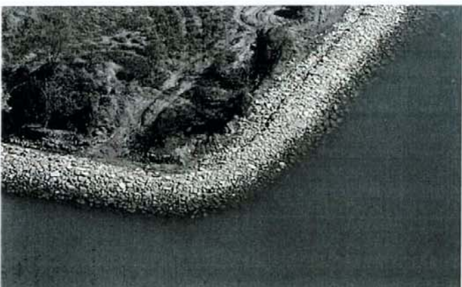
Isola di Poveglia. Un tratto della riva durante i lavori
