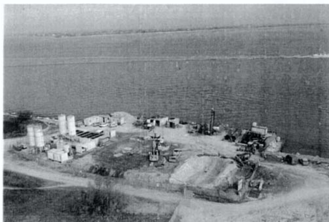
Bocca di Lido - Campo prova dei pali di fondazione
