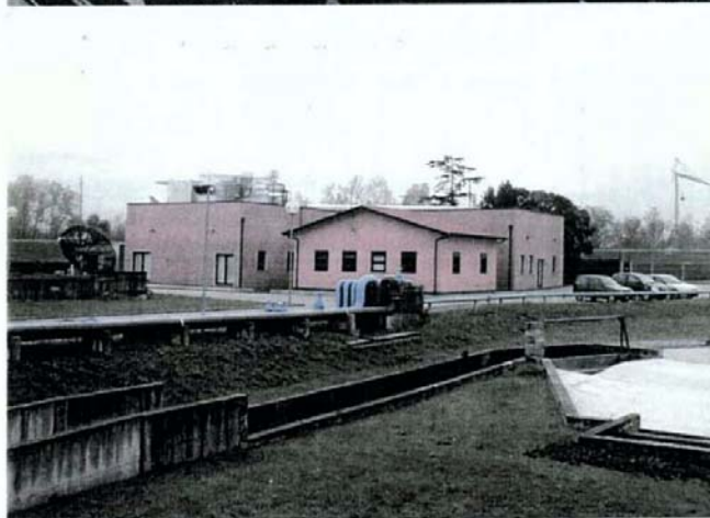
A lato: esterno dell'edificio tecnico
