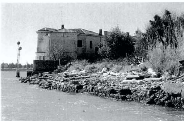
Murano - Canale Ondello la sponda prima degli interventi
