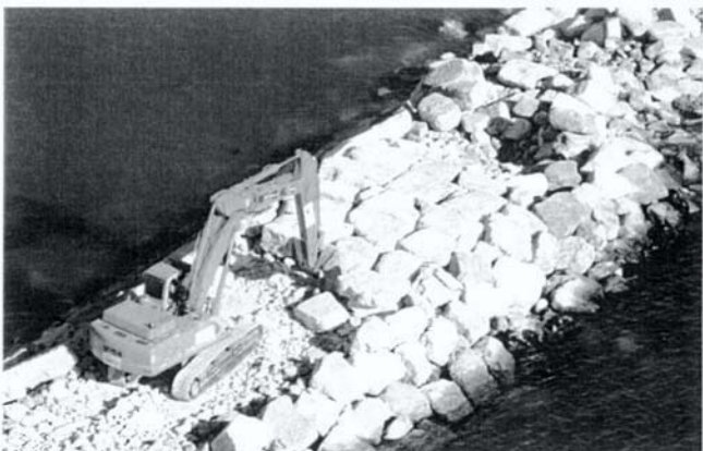
Bocca di Malamocco- Diga foranea. Mezzi in opera
