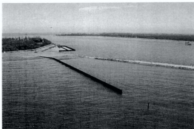
Bocca di Malamocco – Conca di navigazione – camera della conca. Pennello di scogliera e palancoiato metallico provvisionale
