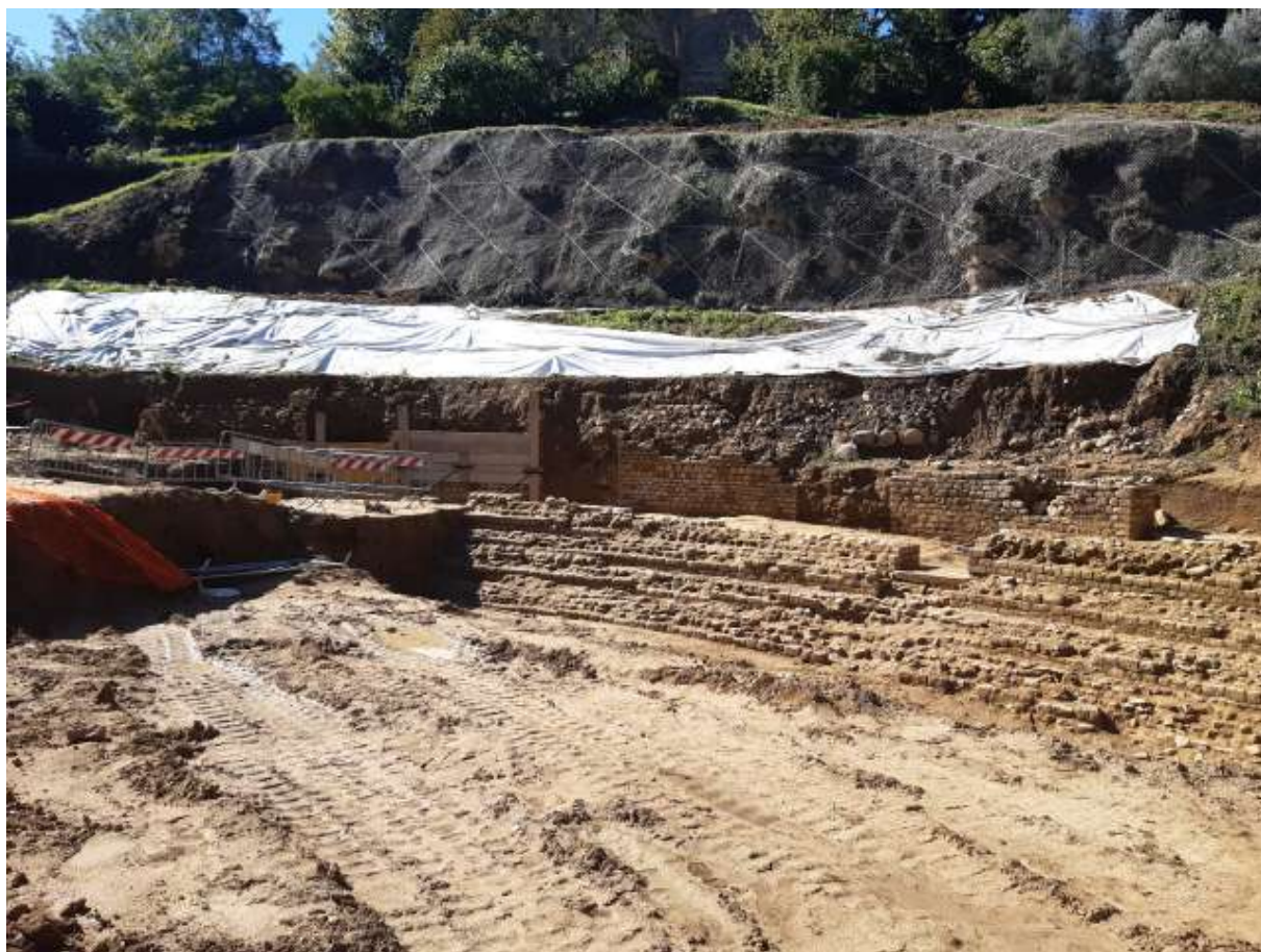
FOTO 5 – SETTORE DI SCAVO B SAGGIO 2, sullo sfondo gli interventi di messa in sicurezza della scarpata.
