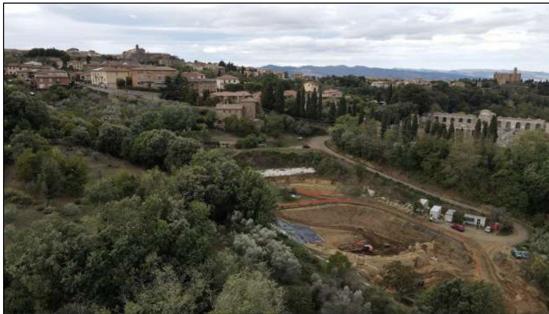
Foto 1 –vista dall'alto dell'Anfiteatro con la strada di accesso al Cantiere.
