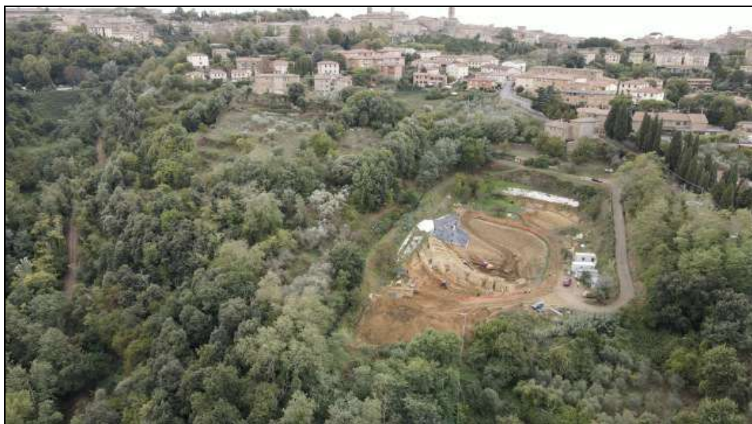
Foto 2 - vista dall'alto dell'Anfiteatro con la strada di accesso al Cantiere.
