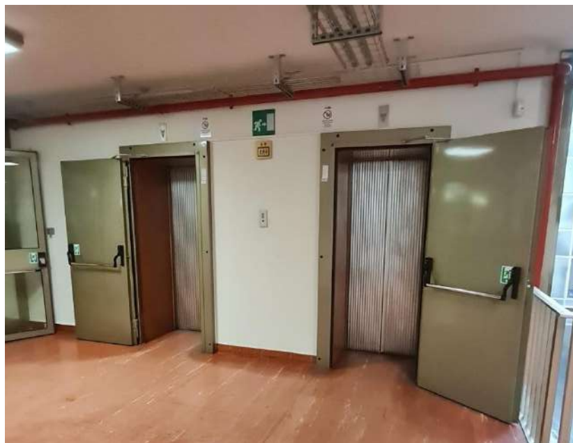
Vecchio impianto (secondo piano Biblioteca) – lavori affidati da iniziare
