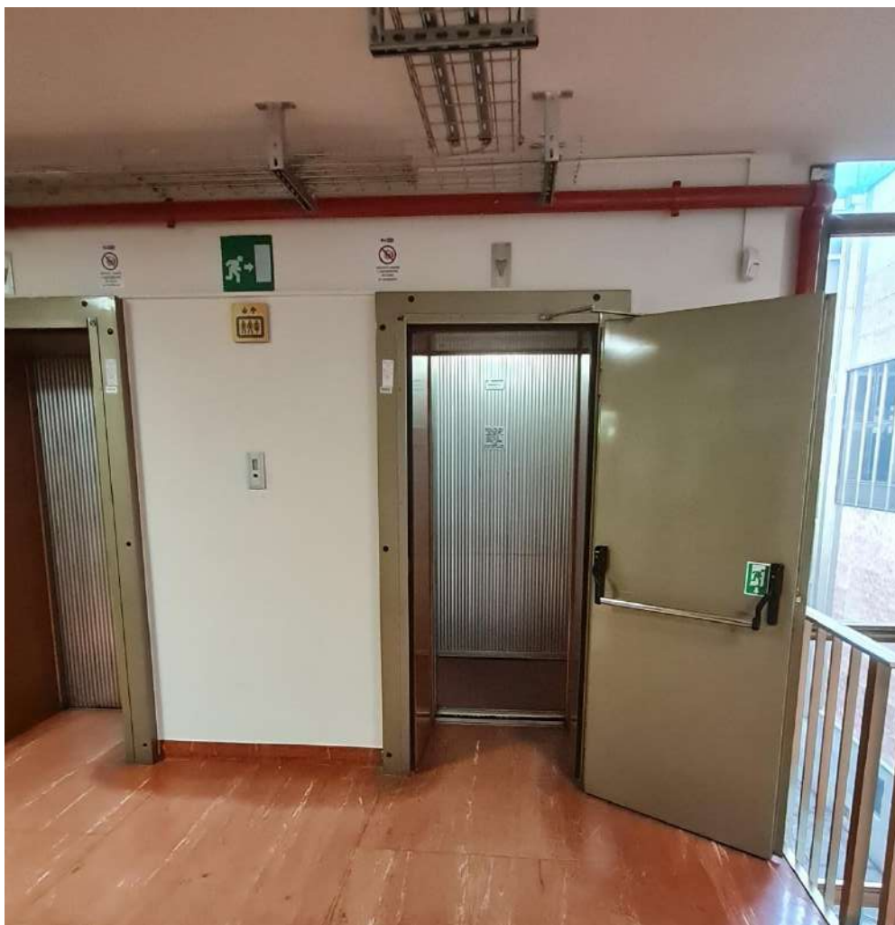
Vecchio impianto (secondo piano Biblioteca) – lavori affidati da iniziare
