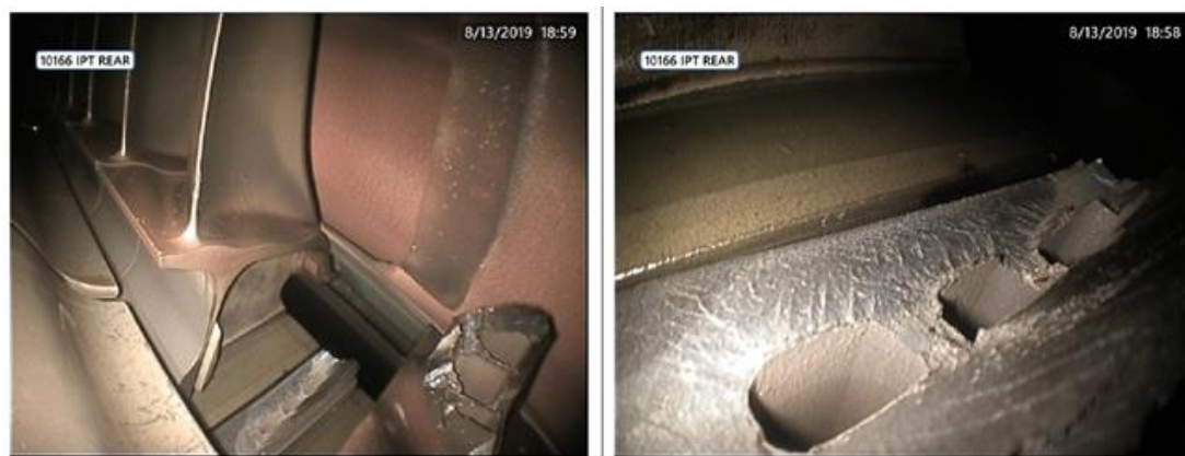
Superfici di rottura delle palette dell'IPT del motore sinistro.
