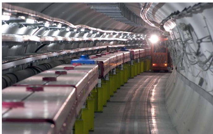
Fisica delle alte energie; il tunnel del Super Proton Synchrotron al CERN di Ginevra
