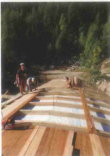
I lavori di realizzazione del 1 lotto del fabbricato del Centro "L'uomo ed i coltivi" sono ripresi in giugno
