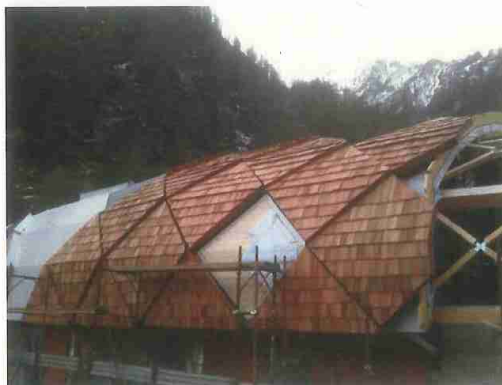
Ad inizio inverno sono stati posizionati gli elementi di copertura a grandi "squame" di scandole che simulano l'embricatura di uno strobilo d'abete
