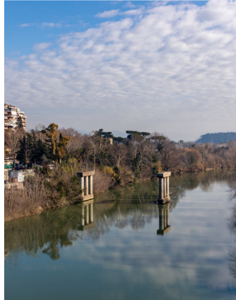
I piloni del Ponte Bailey, 1962-1970
