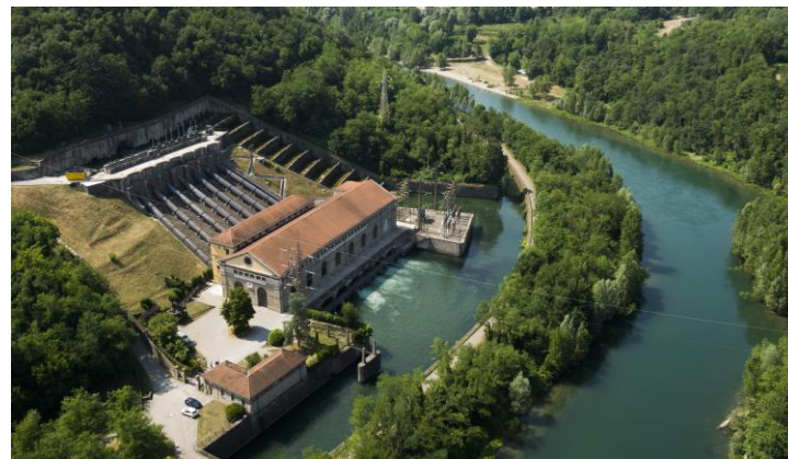
La storica centrale idroelettrica 'Bertini', in esercizio dal 1898
