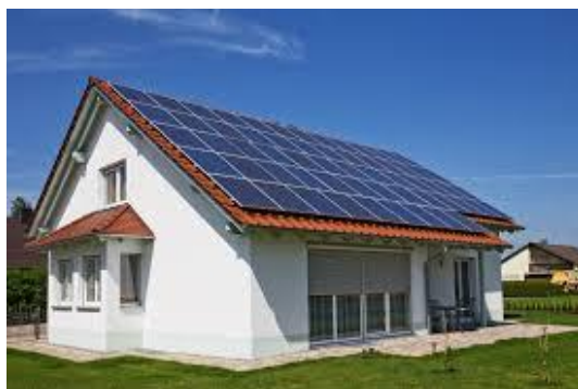
Impianto fotovoltaico su edificio
