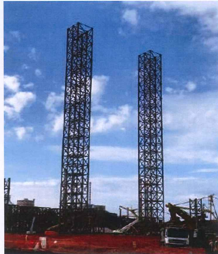
Struttura Provvisoria di sollevamento
