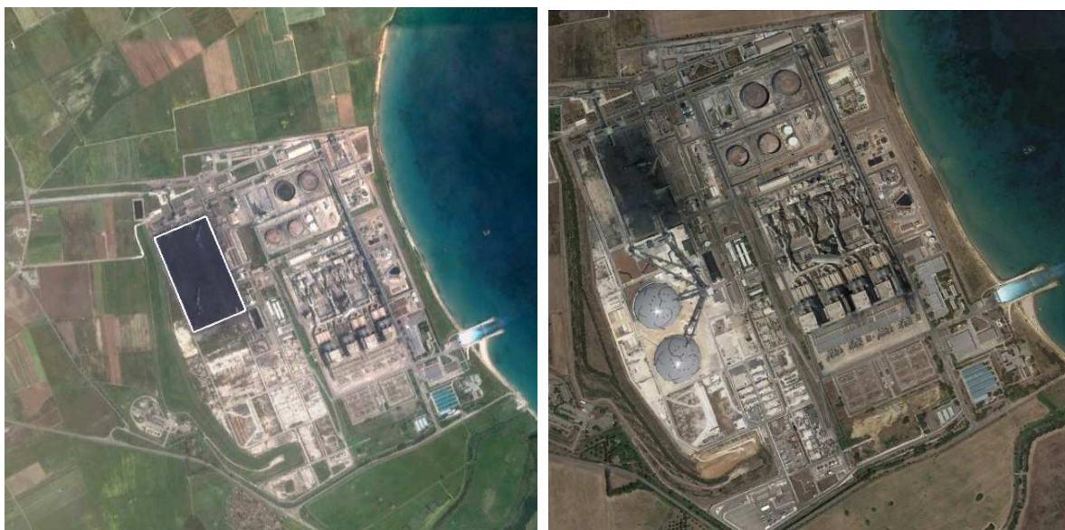
Localizzazione dell'area parco carbonile (area evidenziata in bianco a sx); a destra le due nuove installazioni ("dome" coperti), in sostituzione del parco carbonile
