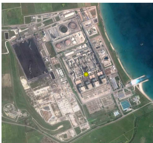
Centrale ENEL di Cerano - Localizzazione delle sorgenti puntuali (i quattro gruppi termici afferiscono ad un'unica torre - punto giallo mappa)
