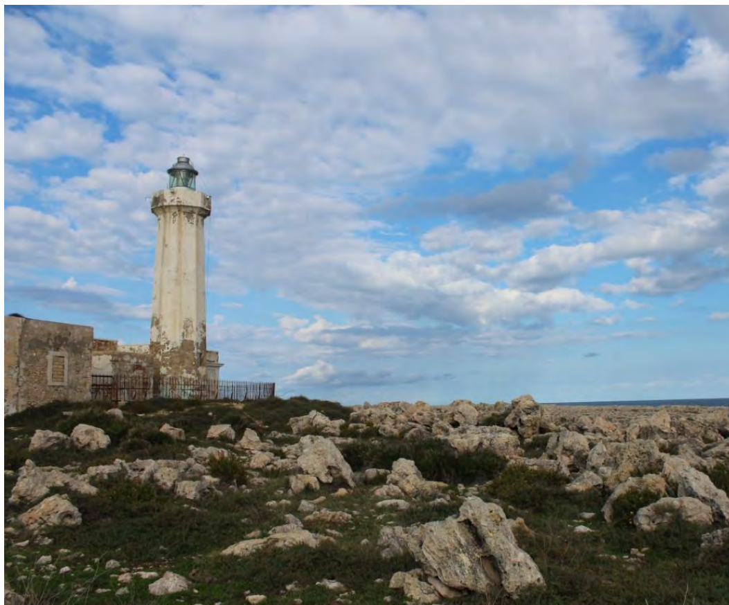
Strada provinciale 110 località Murro di Porco – 96100 Siracusa
