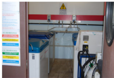
Foto n. 4 - Particolare della sala di criobiologia.
