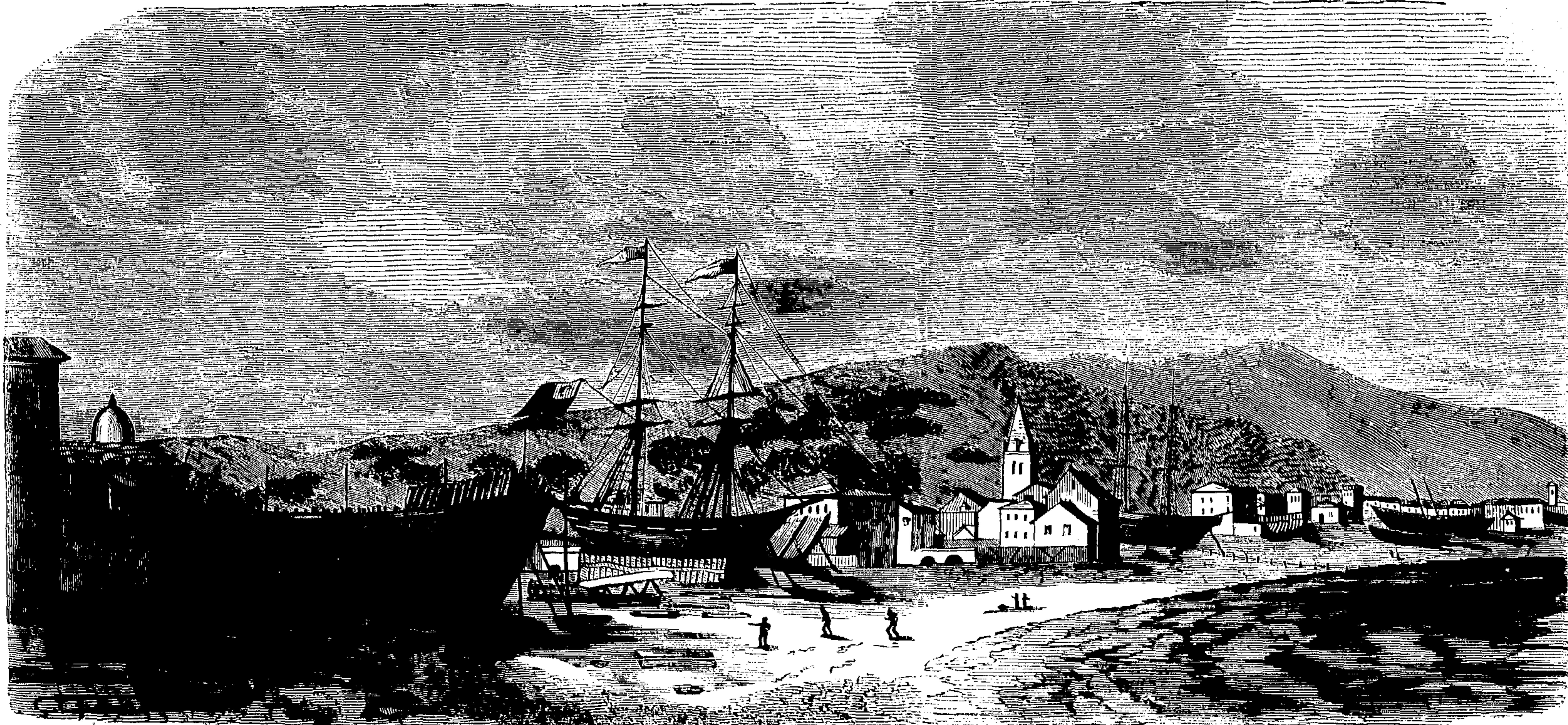
(Cantiere di Varazze)
