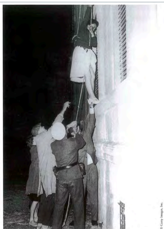
Al momento della divisione della città, Bernauer Strasse diventa una strada di confine e molti edifici si ritrovano ad avere un lato a Est e uno a Ovest. Una donna riesce a raggiungere il settore occidentale calandosi dalla finestra.
