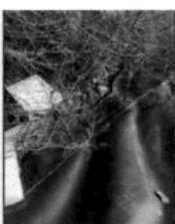
Stato attuale del Telo in HDPE con evidenza di mancanza di giunzioni e vegetazione infestante Zona centrale e sommitale del corpo rifiuti
