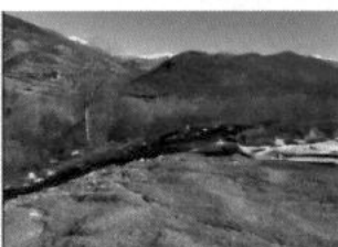
Stato attuale del Telo in HDPE con evidenza di mancanza di giunzioni e vegetazione infestante Zona centrale e sommitale del corpo rifiuti
