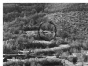
Panoramica del sito dall'esterno del corpo della discarica con evidente porzione di telo HDPE non presente (cerchio rosso)
