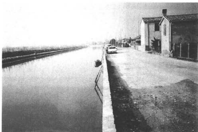
Un tratto di sponda prima dei lavori
