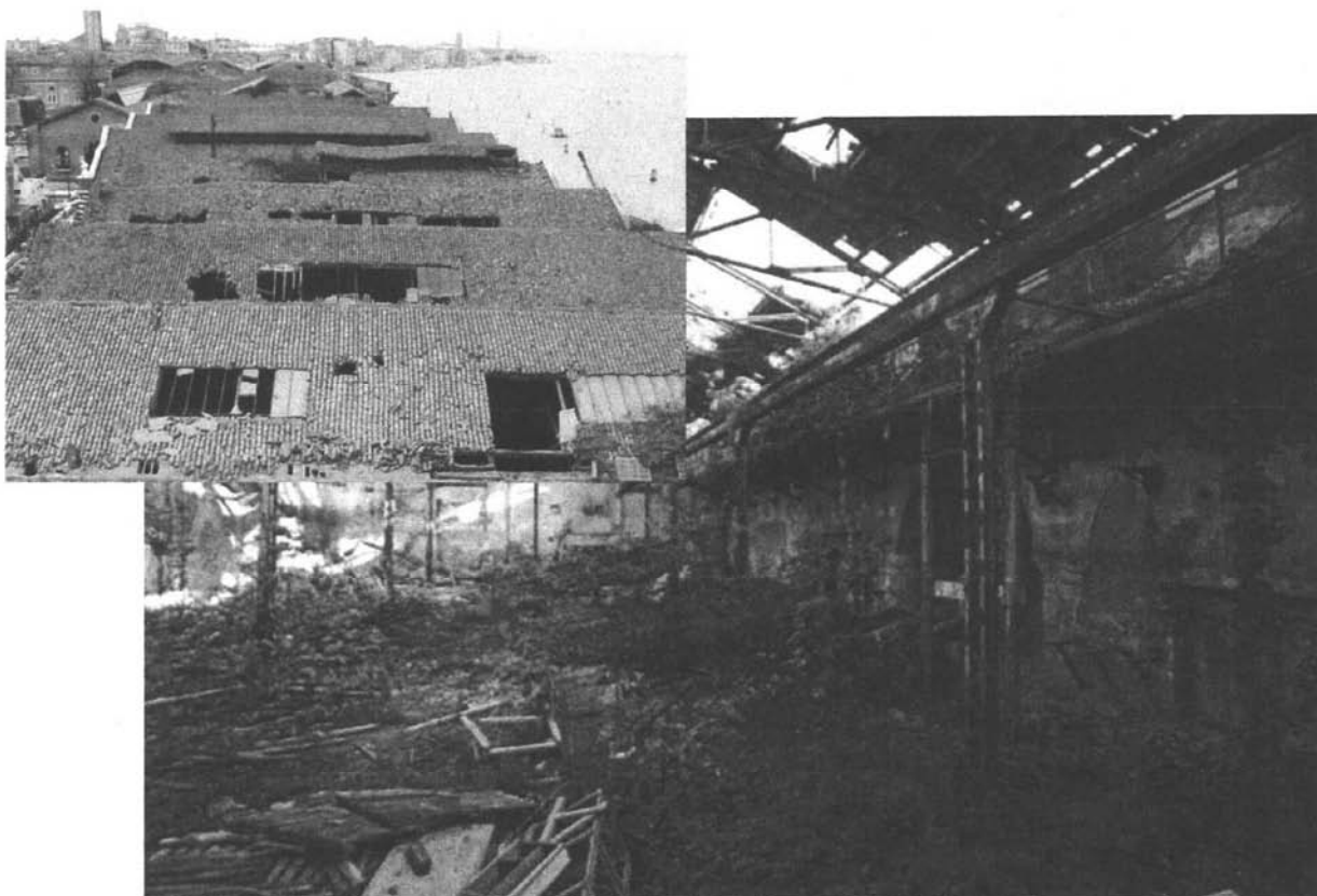
In queste foto, l'interno e l'esterno dell'edificio prima dei lavori
