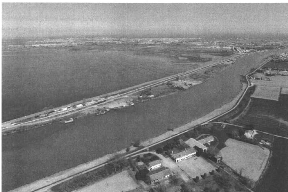
Veduta aerea dei lavori relativi al 2° stralcio, zona da Cà Pasqua a Punta Gorzone
