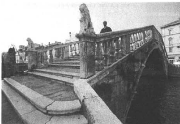
Il ponte Vigo prima dei lavori
