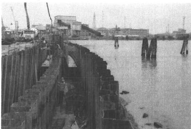
Canale Industriale Ovest sponda est: palancole strutturale infisso all'interno delle ture provvisionali
