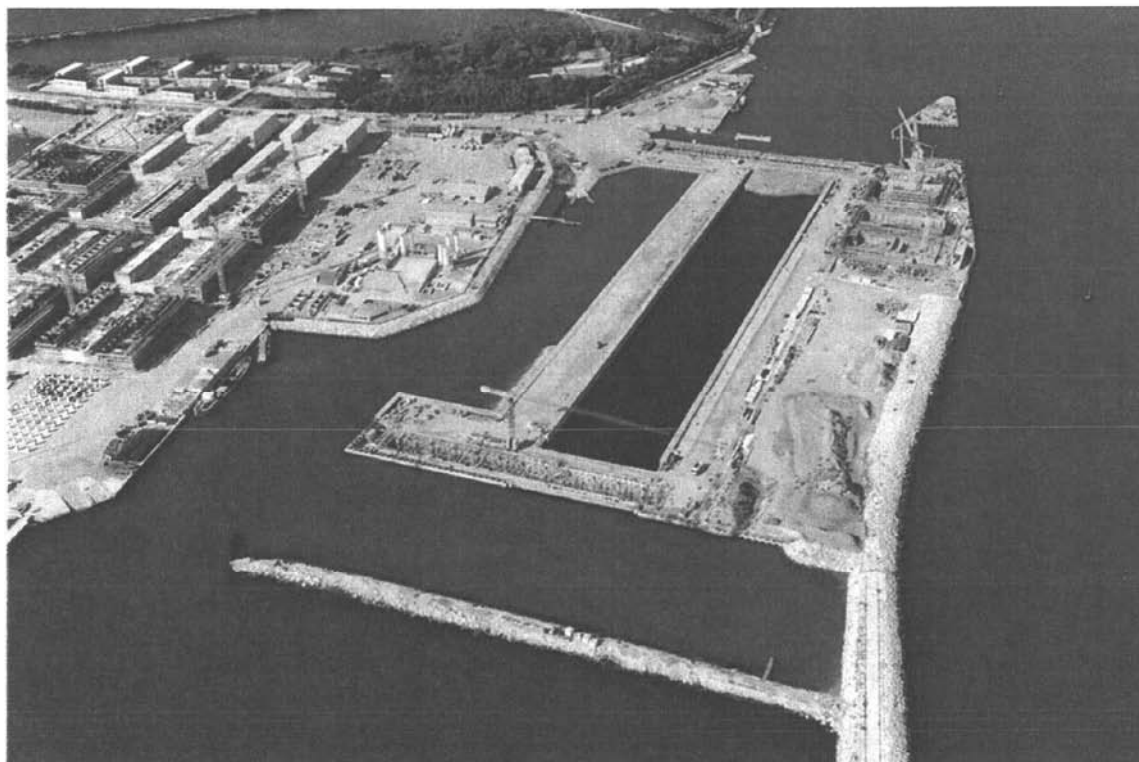
Bocca di Malamocco: veduta d'insieme della conca di navigazione per grandi navi a Malamocco
