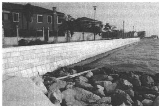
Un tratto di riva dopo i lavori
