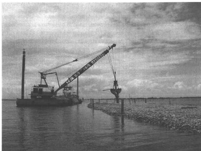
Fase di realizzazione della soffolta
