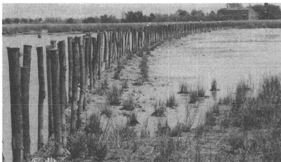
Protezione barene mediante fascinate
