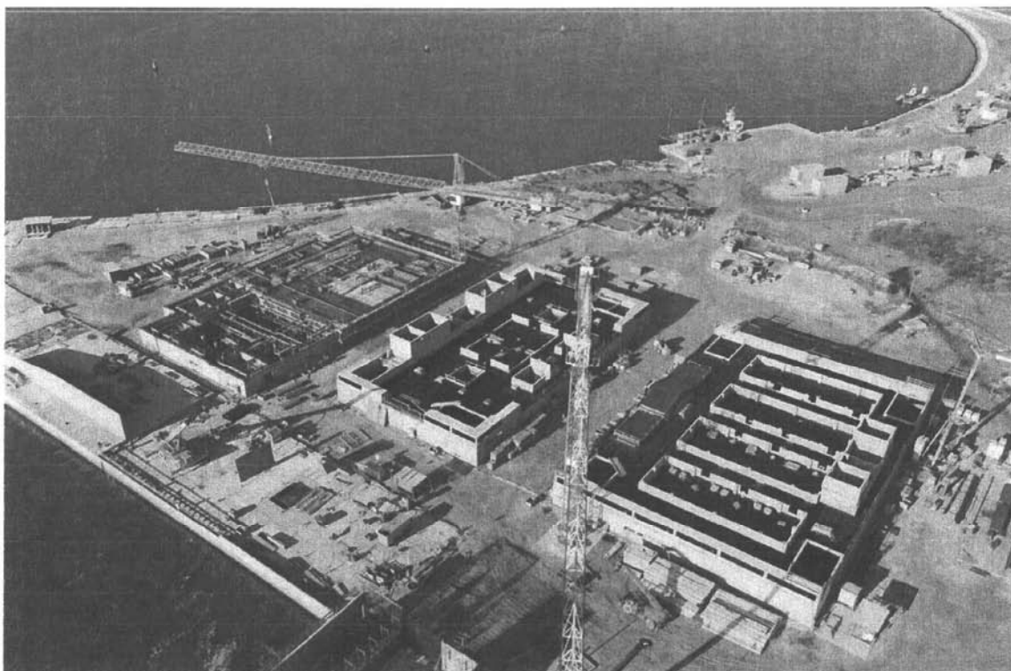
Bocca di Lido - S. Nicolò: strutture di spalla nord di S. Nicolò sull'isola artificiale. In evidenza, gli edifici tecnici che ospiteranno gli impianti per il funzionamento delle barriere
