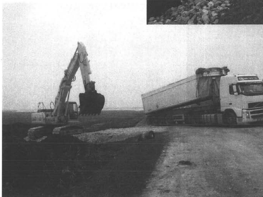
Un tratto di argine dopo gli interventi
