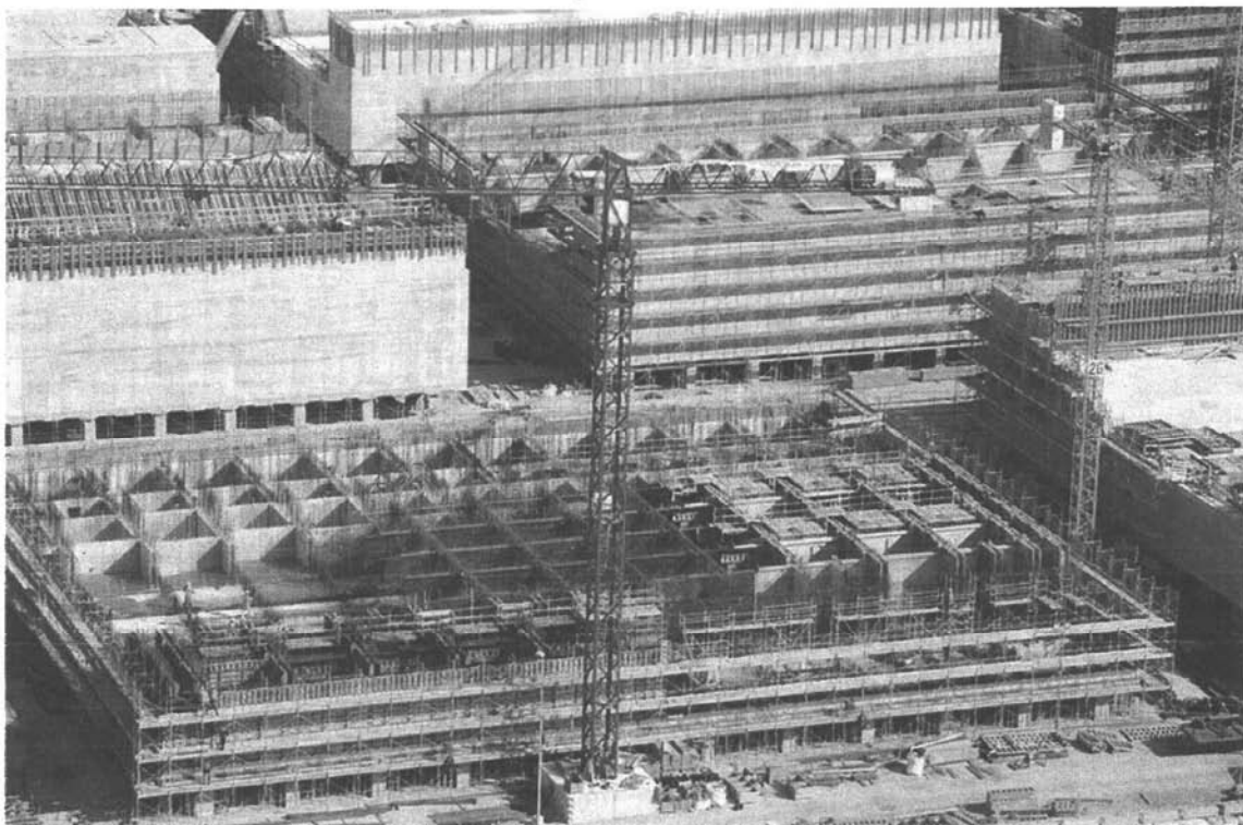
Bocca di Malamocco: particolare delle lavorazioni di prefabbricazione dei cassoni
