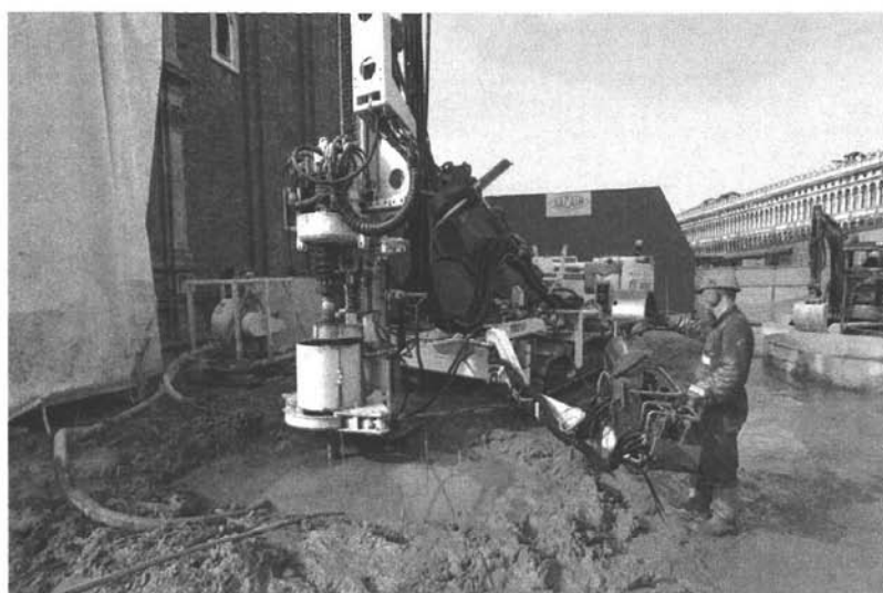
Lavori di consolidamento delle fondazioni, attività per la realizzazione della cameretta nord est
