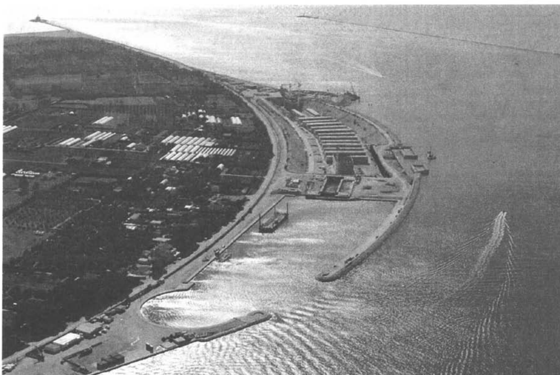
Bocca di Lido - Treporti: veduta di insieme delle lavorazioni a Treporti. In primo piano, il bacino lato laguna
