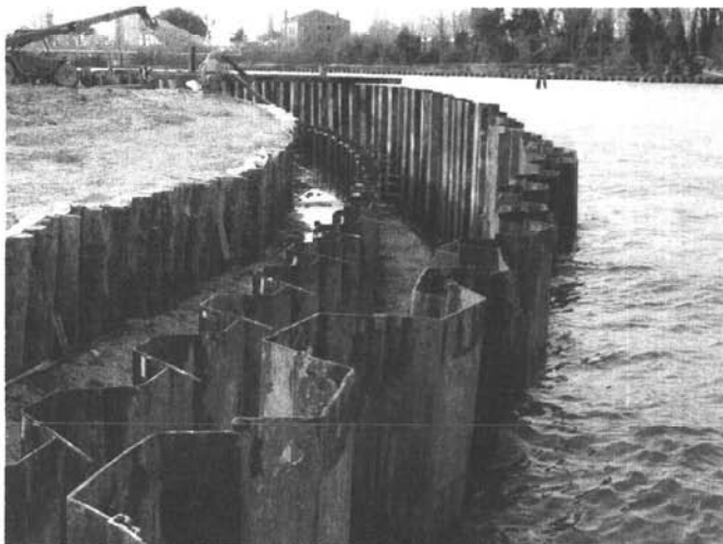
Isola delle Statue: pista perimetrale, palancole strutturale e palancole provvisionali (sponda ovest)
