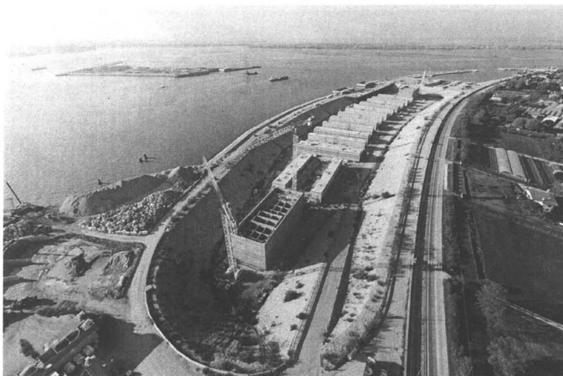
Bocca di Lido - Treporti: in primo piano, il bacino lato mare messo all'asciutto e utilizzato come tura per la prefabbricazione dei cassoni, tutti completati ad eccezione dei due cassoni di spalla, i quali sono comunque in avanzata fase di esecuzione
