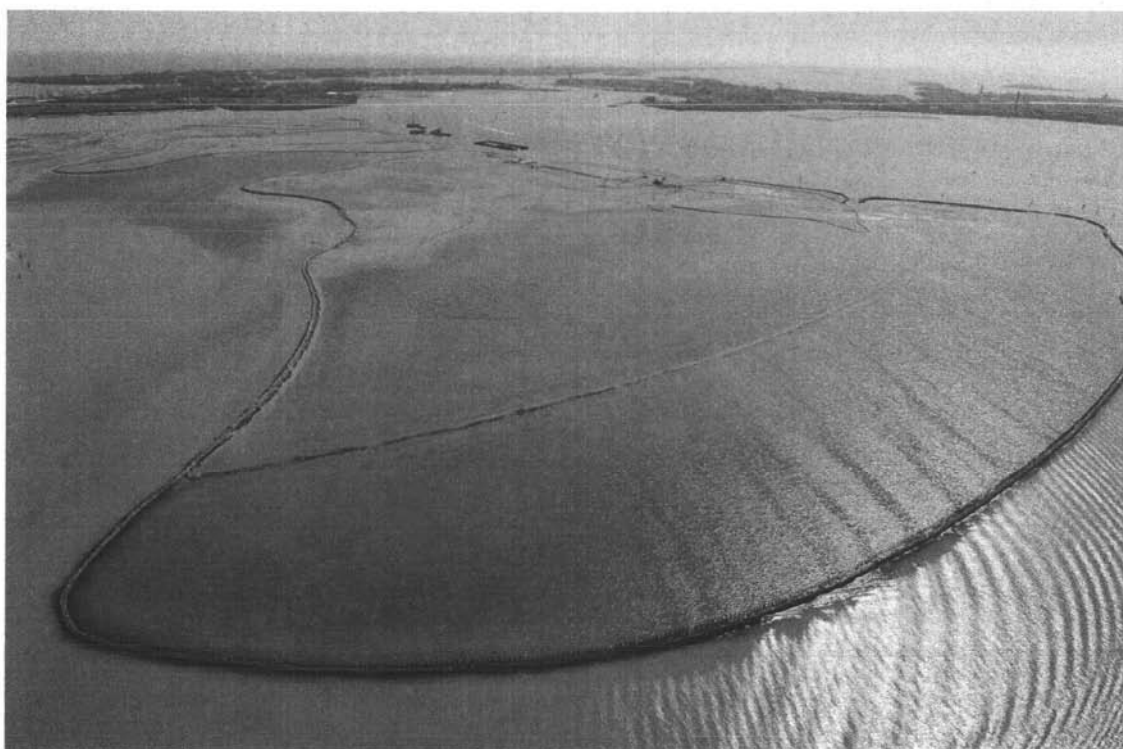
In queste foto, le diverse tipologie di conterminazione delle barene con burghe di vario tipo, l'opera soffolta a protezione del moto ondoso realizzata sempre in burghe e materassi
