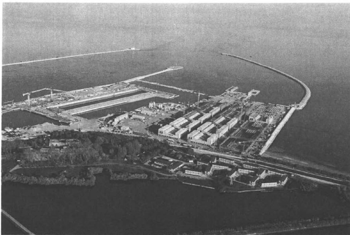
Bocca di Malamocco : veduta d'insieme del rilevato provvisorio sul quale sono eseguite le lavorazioni di prefabbricazione dei cassoni di soglia per le barriere di Malamocco e di San Nicolò
