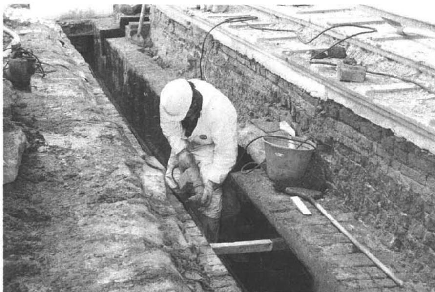
Pulizia e restauro cunicolo. Attività propedeutica alla posa della membrana bentonitica
