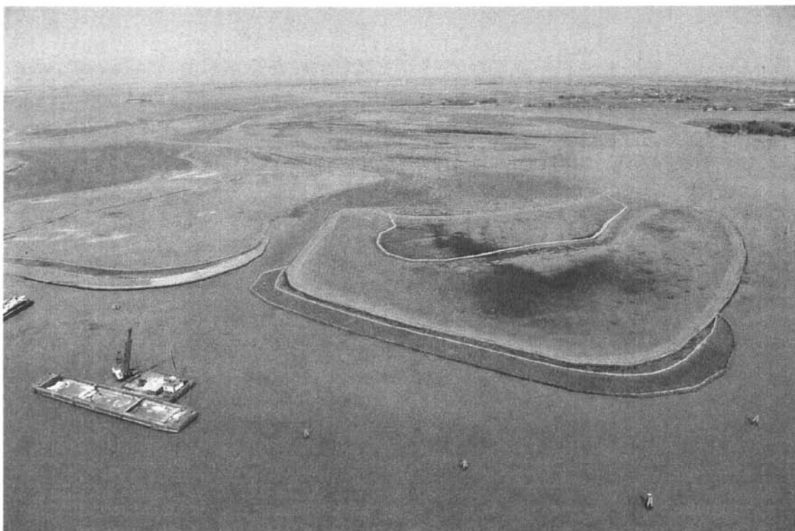
In queste foto, i pali per la posa della barriera antitorbidità nella fase di refluento e la fossa di travaso con le relative draghe per il refluento del materiale in barena
