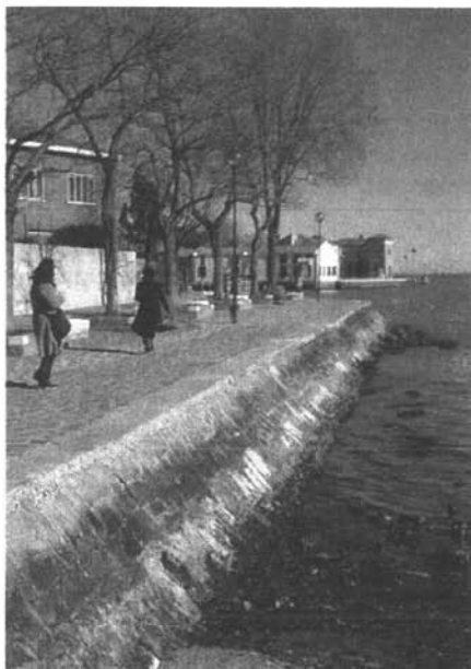
Un tratto di riva prima dei lavori
