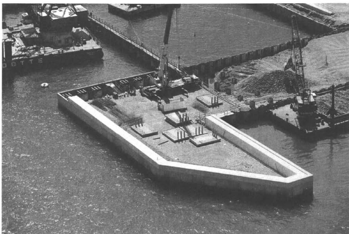
Bocca di Chioggia: lavorazioni per la realizzazione della spalla sud della barriera di Chioggia
