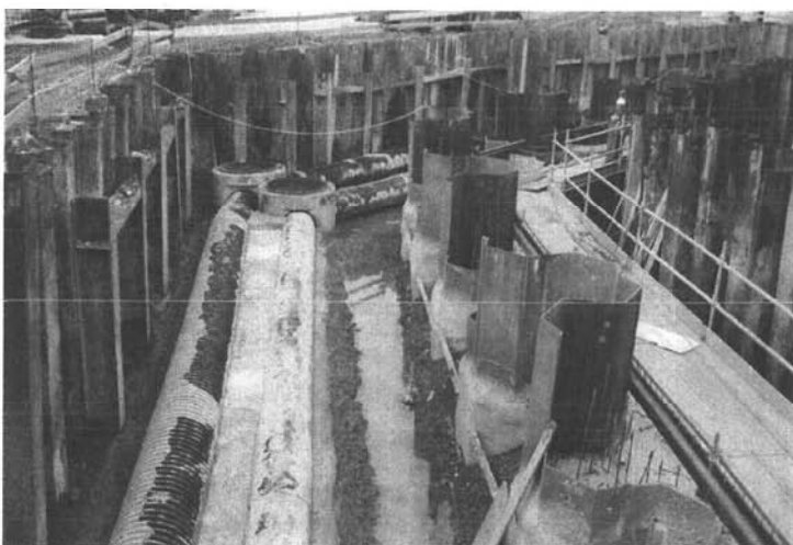
Canale Industriale Sud sponda sud e darsena terminale tratto Pagnan - Colacem: realizzazione del cordolo di sommità al palancole strutturale e inserimento condotte PIF all'interno delle ture provvisionali
