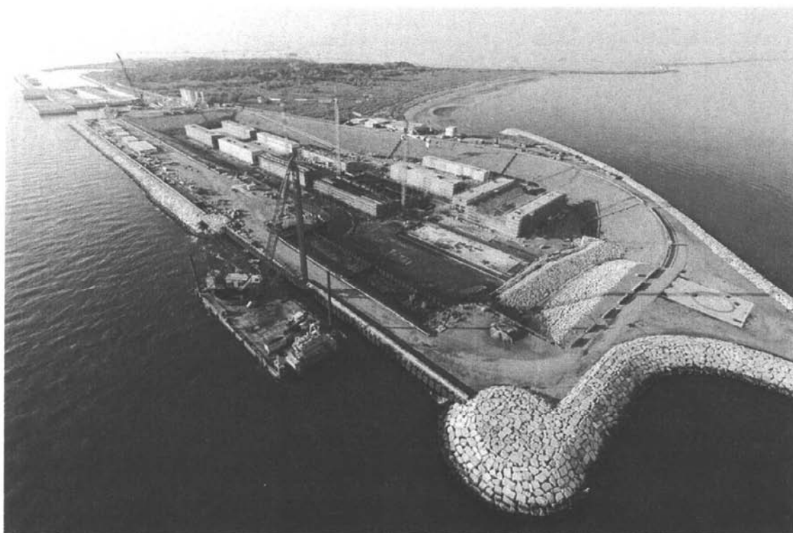
Bocca di Chioggia : il bacino del porto rifugio lato mare. Il bacino è stato messo all'asciutto e utilizzato come "tura" per la prefabbricazione dei cassoni di alloggiamento delle paratoie della barriera di Chioggia
