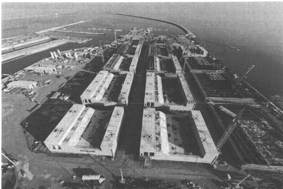
Bocca di Malamocco: particolare delle lavorazioni di prefabbricazione dei cassoni, ormai in fase avanzata di realizzazione
