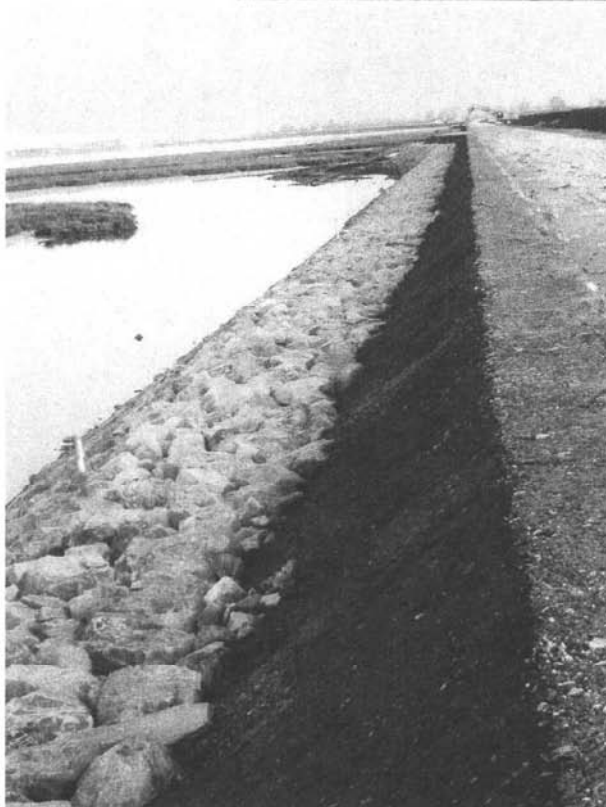
Ingrosso con massi di media/grossa pezzatura a protezione del margine e della sede stradale
