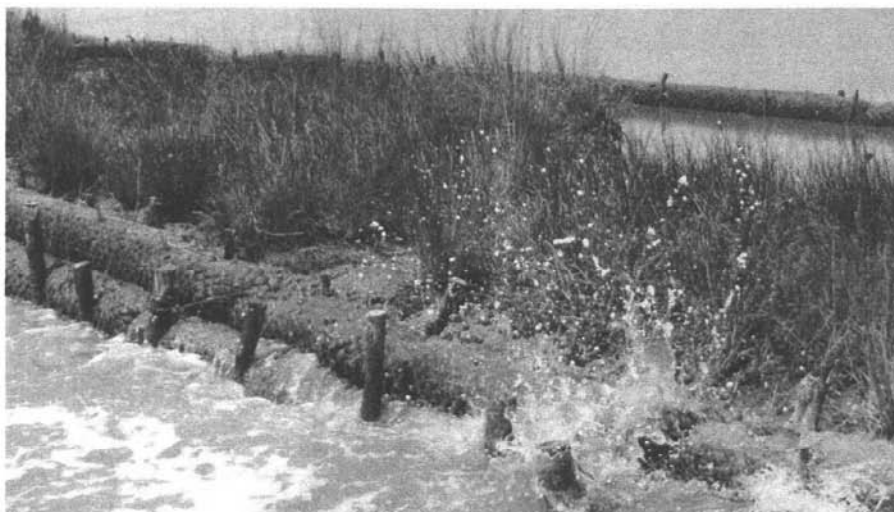
Protezione barene mediante buzzoni
