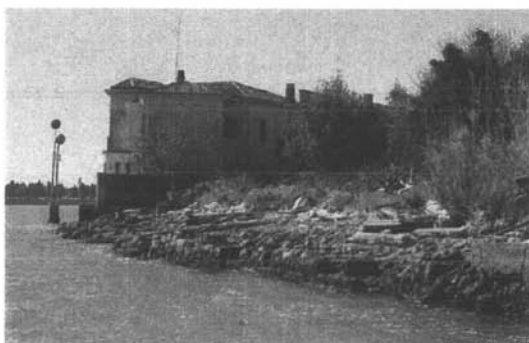
Un tratto di riva prima dei lavori nel canale Ondello
