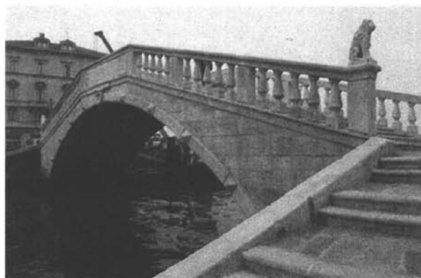
Il ponte Vigo dopo i lavori
