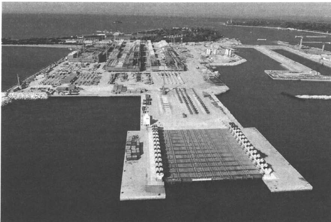
Bocca di Malamocco : veduta d'insieme del rilevato provvisorio sul quale sono eseguite le lavorazioni di prefabbricazione dei cassoni di soglia e di spalla per le barriere di Malamocco e di San Nicolò. In primo piano, il sistema Syncrolift per il varo dei cassoni
