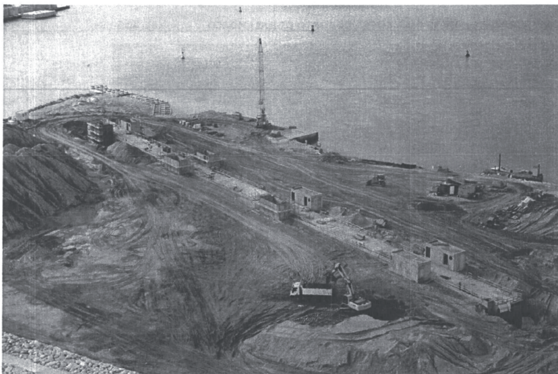
Bocca di Lido : sull'isola nuova, i lavori per la realizzazione del tunnel in cui verranno poste alcune opere elettromeccaniche per il funzionamento delle paratoie
