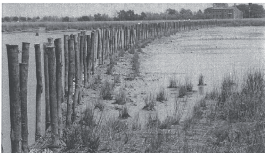
Protezione barene mediante fascinate
