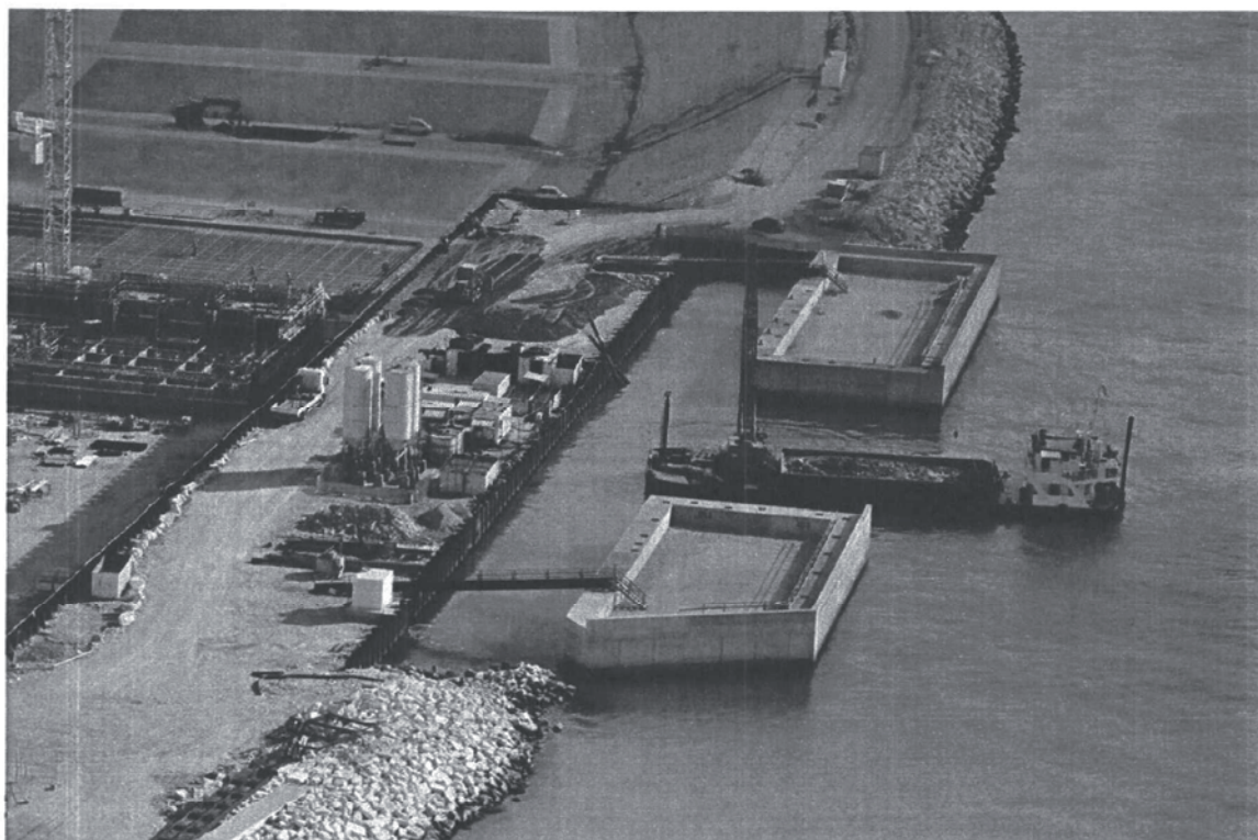
Bocca di Lido - Treporti : a destra, i cassoni prefabbricati in calcestruzzo armato che costituiscono la struttura della spalla est della barriera di Treporti, già posizionati e zavorrati
