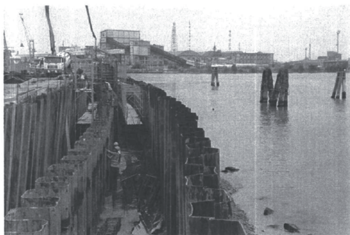
Canale Industriale Ovest sponda est: palancolato strutturale infisso all'interno delle ture provvisionali
