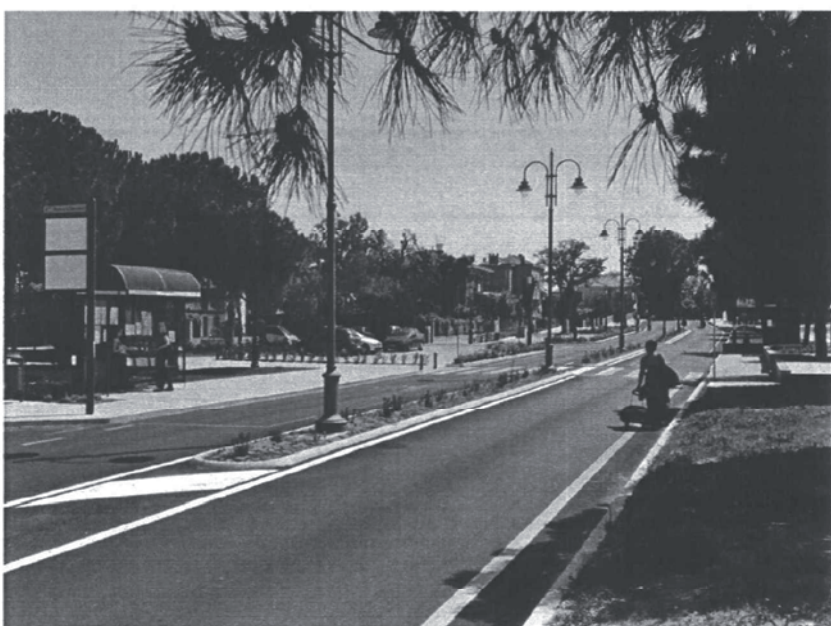
Nuovo assetto della viabilità in Piazzale Malamocco. La strada è stata dotata di aiuole spartitraffico, lampioni, passaggi pedonali, marciapiedi attrezzati
