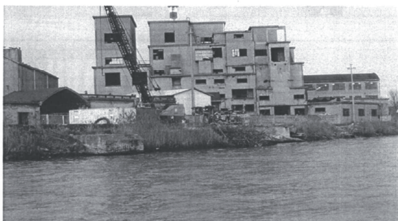
Canale Industriale Brentella: stato di fatto di un tratto di marginamento
