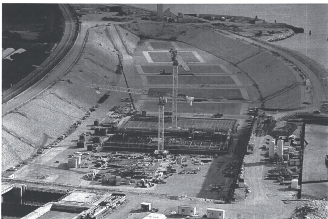
Bocca di Lido - Treporti : in primo piano, il bacino lato mare messo all'asciutto per essere utilizzato come tura per la prefabbricazione dei cassoni sui quali verranno incernierate le paratoie della barriera di Treporti
