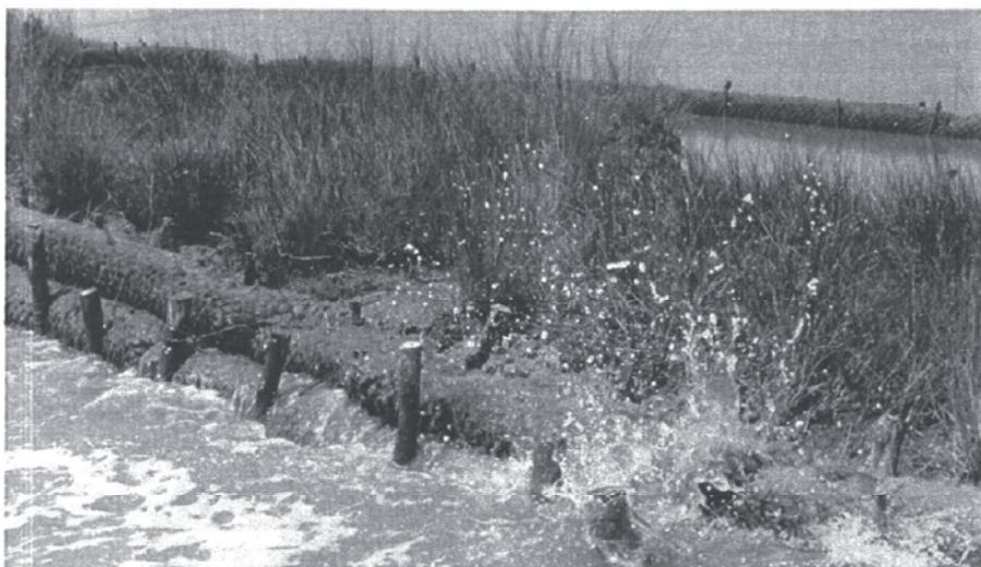
Protezione barene mediante buzzoni
