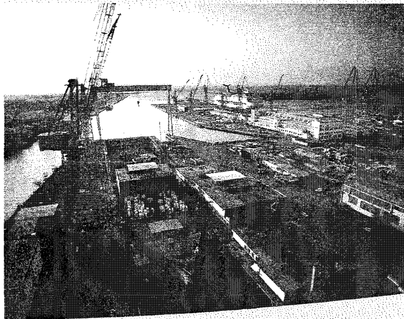
Il cantiere di Monfalcone. The shipyard at Monfalcone.
