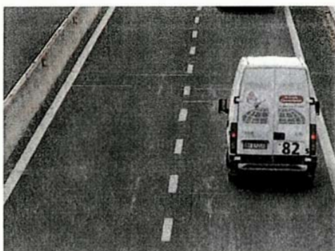
Fig. 3 – Vista di alcuni dispositivi (spire e sensori peso) annegati nella pavimentazione stradale
