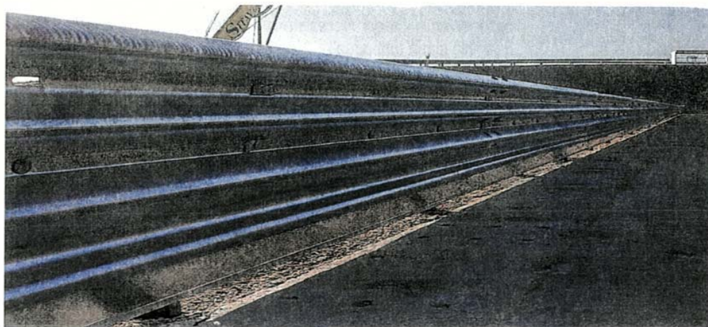
Figura 2: Aspetto della barriera montata
