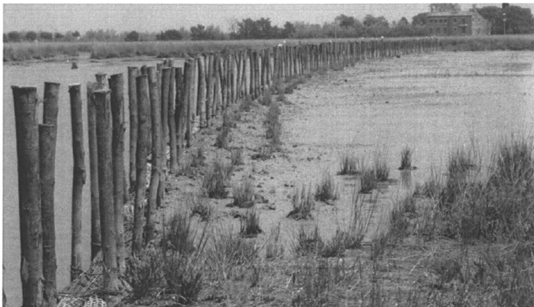
Protezione barene mediante fascinate.
