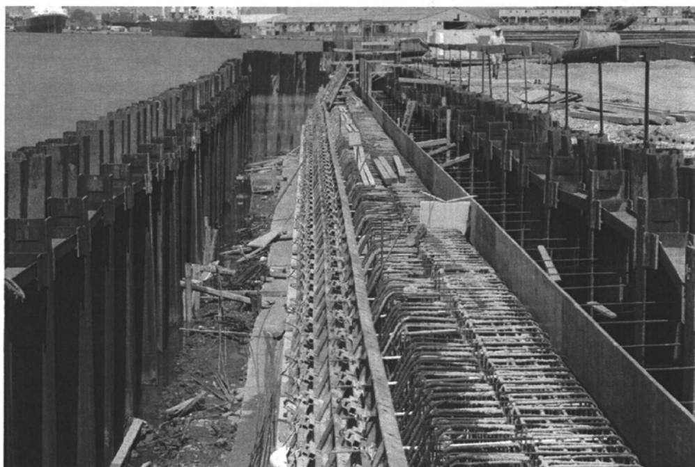
Fase di realizzazione del cordolo sommitale
