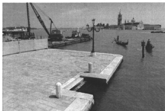
Difesa rive bacino S. Marco tra Ponte della Paglie e Ponte del Vin. Un tratto della riva a lavori ultimati.
