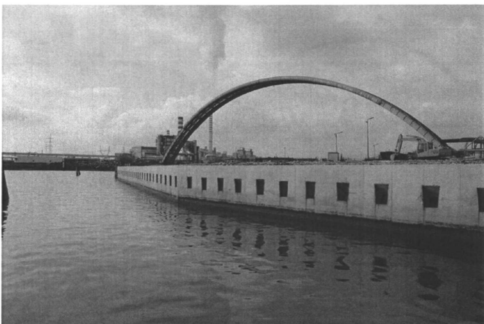
Marginamento in fase di ultimazione nel tratto della sponda della penisola del nuovo petrolchimico in prossimità del bacino di evoluzione n. 4
