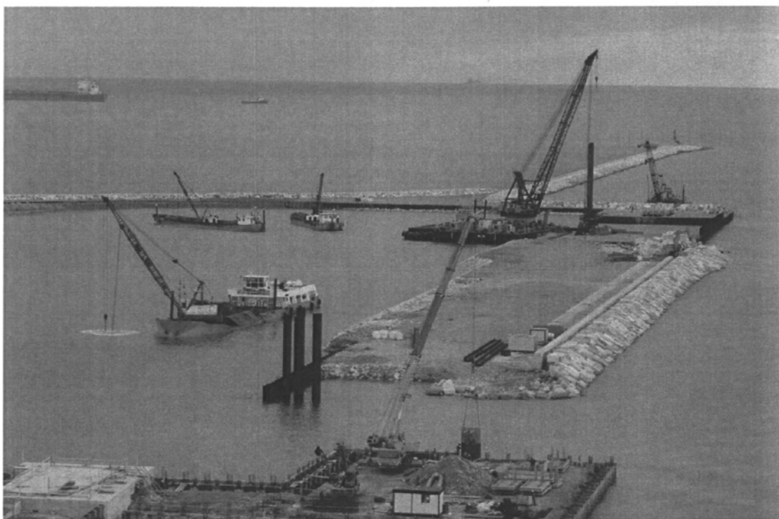
Bocca di Chioggia : mezzi al lavoro all'interno del porto rifugio. Sulla sinistra draghe per lo scavo dei fondali, in alto a destra un pontone per l'infissione delle palancole al fine di impermeabilizzare il bacino lato mare del porto rifugio per la successiva messa all'asciutto.
