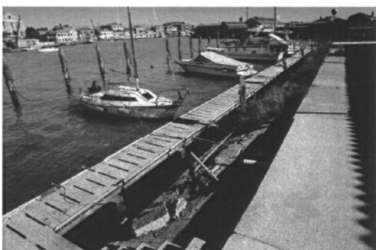
Un tratto di riva prima dei lavori nel canale degli Angeli.
