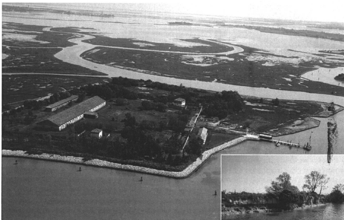
Vista aerea dell'isola del Lazzaretto Nuovo dopo i lavori di consolidamento delle rive, in primo piano la sponda ovest. Nella foto piccola, un tratto della sponda ovest prima dei lavori.
