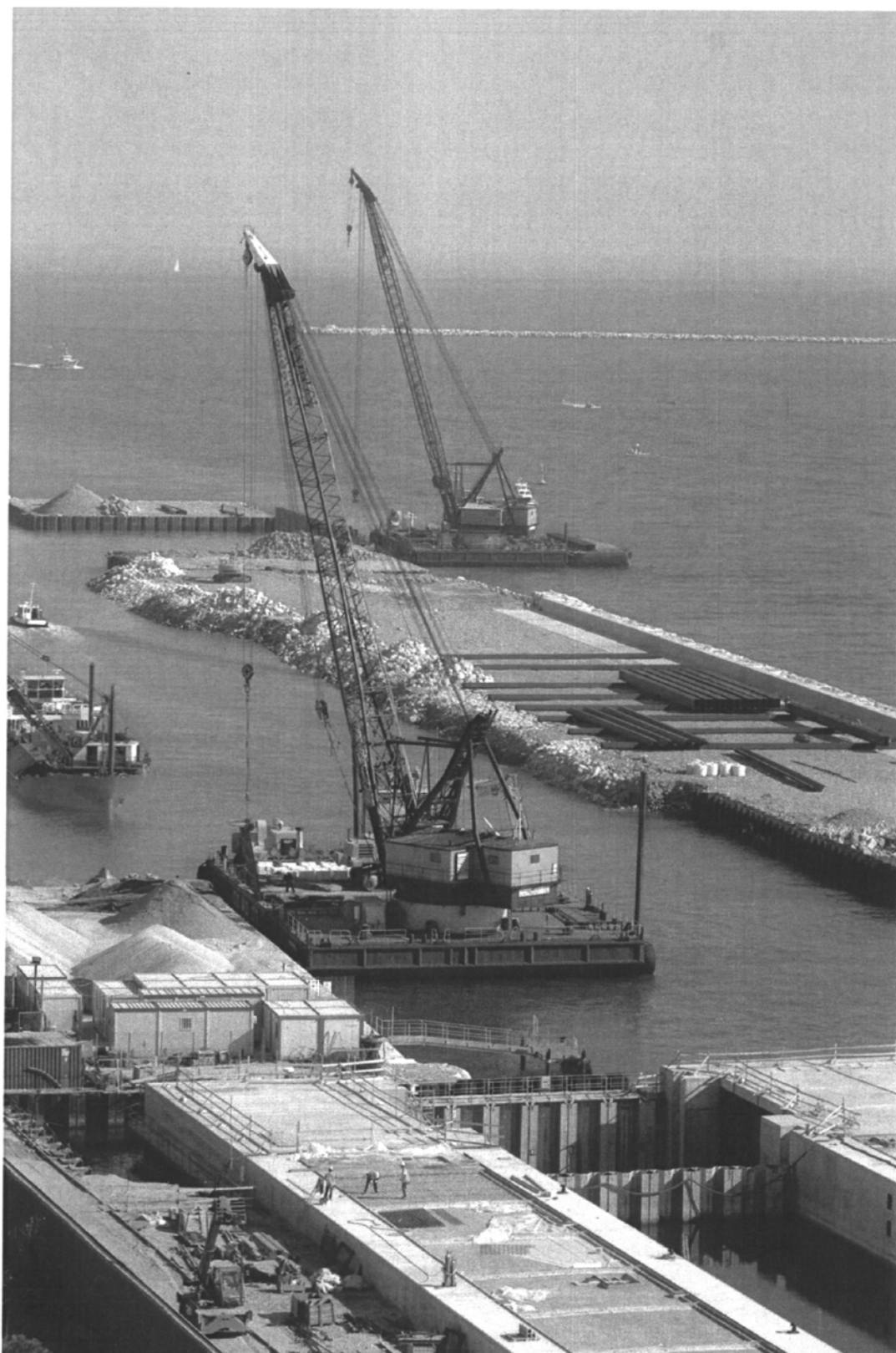
Bocca di Chioggia : in basso la conca di navigazione. Al centro attività in corso per la realizzazione del porto rifugio – tura di prefabbricazione.
