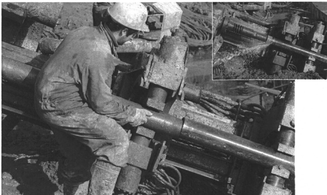
Fase di realizzazione dei tiranti sul cordolo di marginamento
