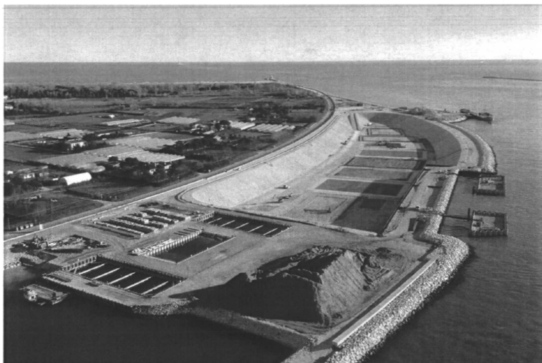
Bocca di Lido - Treporti : particolare della camera della conca di navigazione e dei recessi che ospiteranno le porta della conca in comunicazione con il porto rifugio lato mare. Sullo sfondo la tura di prefabbricazione dei cassoni.
