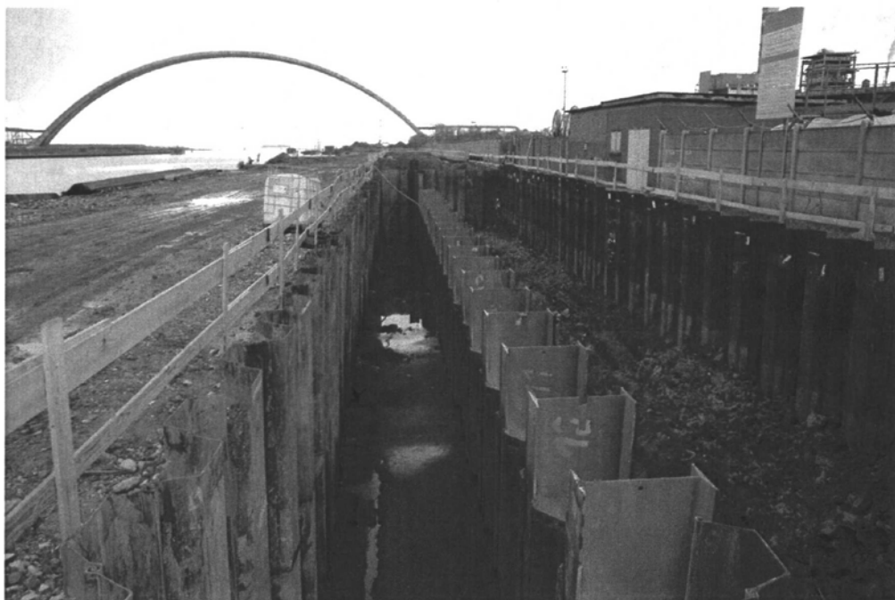
Canale industriale sud sponda sud, area Fassa ex Edison. Palancolato strutturale infisso all'interno della tura provvisoria per la realizzazione di un tratto di marginamento
