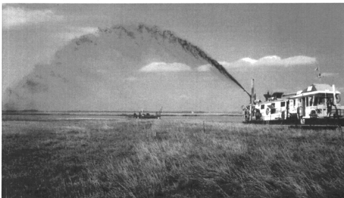
Protezione barene mediante rinascimento.
