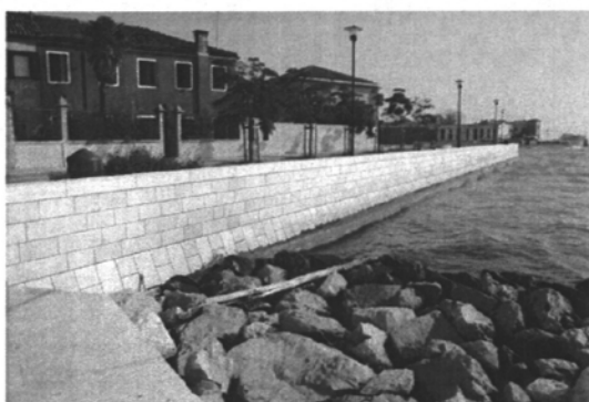
Un tratto di riva dopo i lavori.
