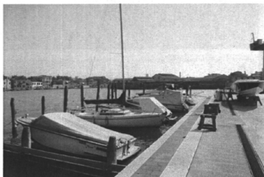
Un tratto di riva dopo i lavori nel canale degli Angeli.
