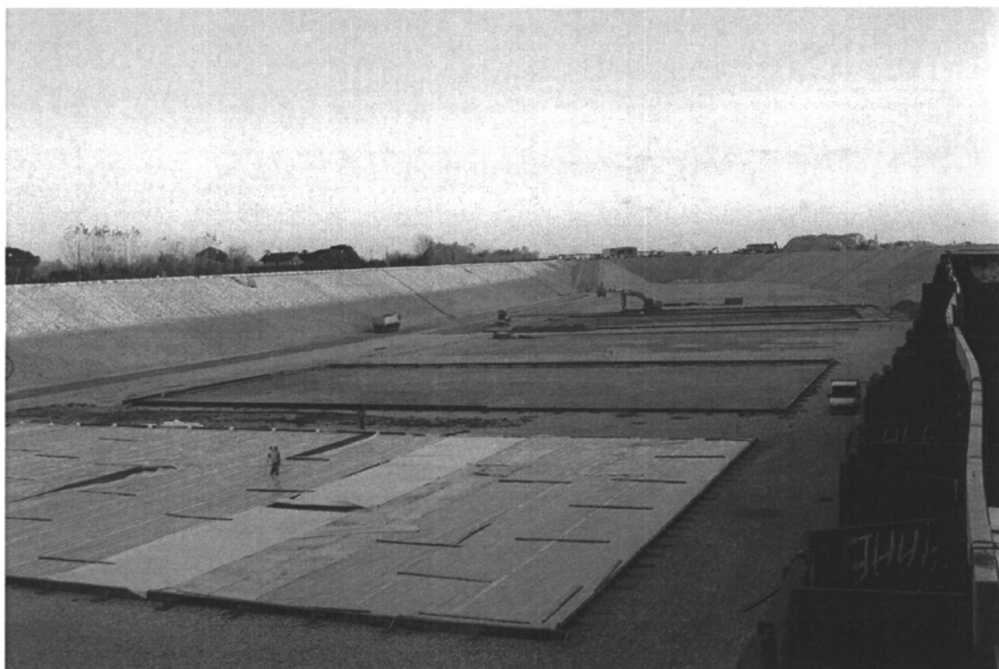
Bocca di Lido - Treporti : particolare del bacino del porto rifugio lato mare messo all'asciutto, con in primo piano la costruzione delle piastre di appoggio per la prefabbricazione dei cassoni.
