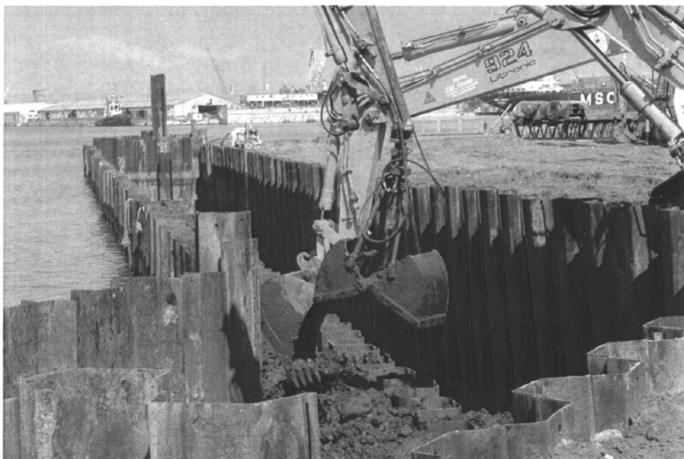
Fase di realizzazione delle opere di scavo preliminari alla realizzazione del cordolo sommitale, sul palancolato strutturale, all'interno delle tute provvisionali
