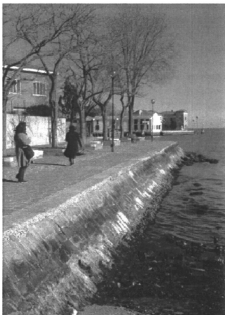
Un tratto di riva prima dei lavori.
