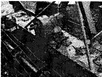
Machina non sufficientemente protetta
