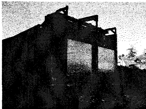
Esempio di dispositivo di chiusura posteriore ad azionamento idraulico
