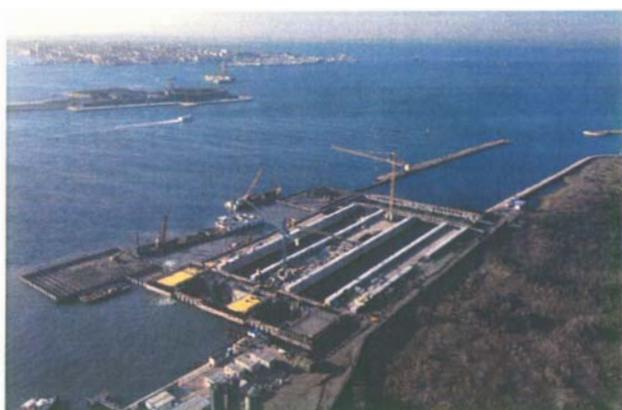
Bocca di Chioggia - Spalla nord della barriera: la spalla nord della barriera dovrà raccordarsi con le strutture di nuova costruzione, lungo il canale di bocca lato Cà Roman, relative al porto rifugio, nel tratto in cui verranno realizzate le due conche di navigazione parallele
