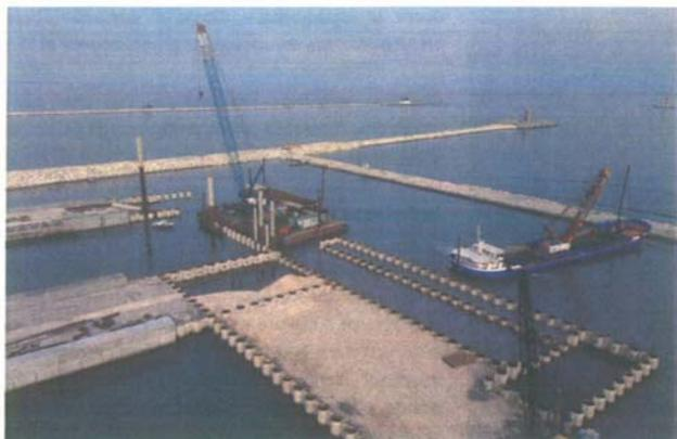
Conca di navigazione - opere civili per l'alloggiamento delle porte e delle strutture guida: parete combinata della testata lato mare, in fase di infissione
