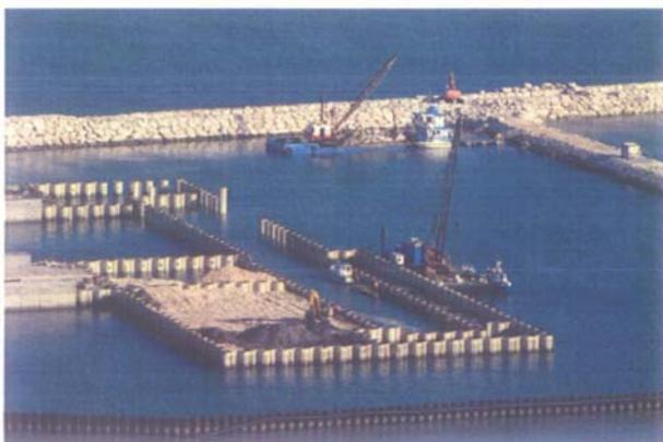
Conca di navigazione: riempimenti e stesa del materiale all'interno della parete combinata della testata lato mare
