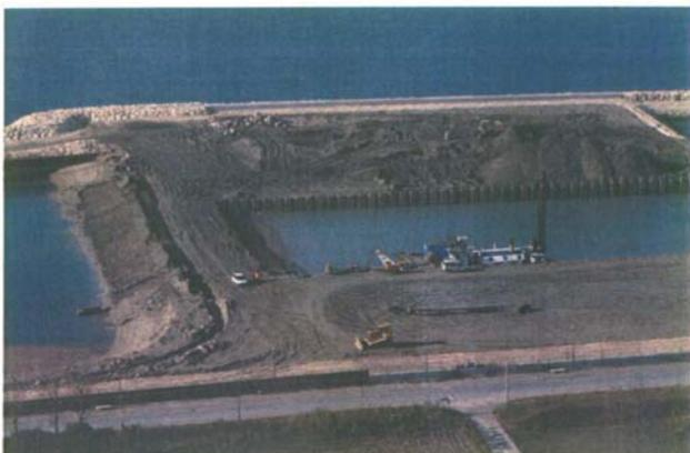
Il porto rifugio lato mare: terrapieni a servizio della conca di navigazione e chiusura della testata in corrispondenza del porto rifugio. Mezzi in attività per la realizzazione dell'aggottamento del bacino lato mare, per la sua messa all'asciutto e utilizzo dello stesso come tura di prefabbricazione dei cassoni di alloggiamento delle paratoie
