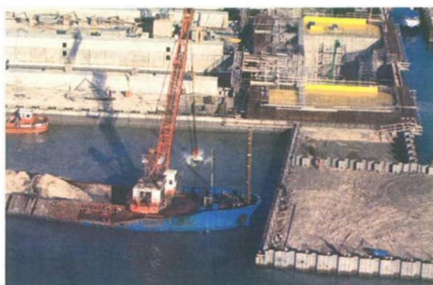
Spalla nord 1^ stralcio: attività di dragaggio in corrispondenza del recesso della spalla nord. Sulla destra il riempimento del terrapieno d'ala lato mare. In secondo piano le conche di navigazione con gli impalcati in fase di realizzazione
