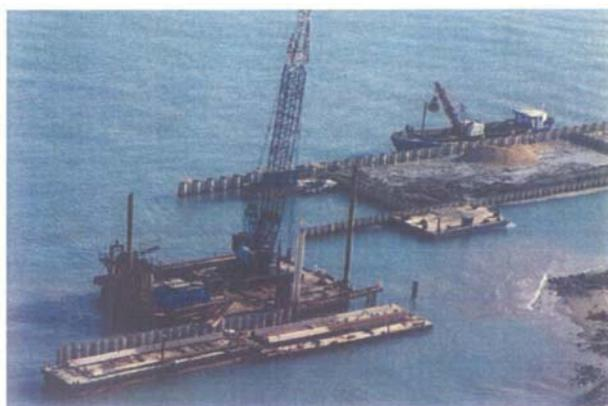
Mezzi in azione per l'infilazione dei palancotati della spalla ovest e il riempimento al loro interno
