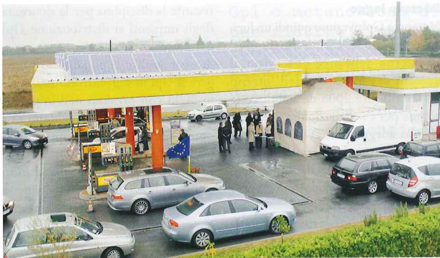
Le nuove aree di servizio dovranno essere dotate di un impianto fotovoltaico, o di altre fonti rinnovabili per la produzione di energia elettrica
