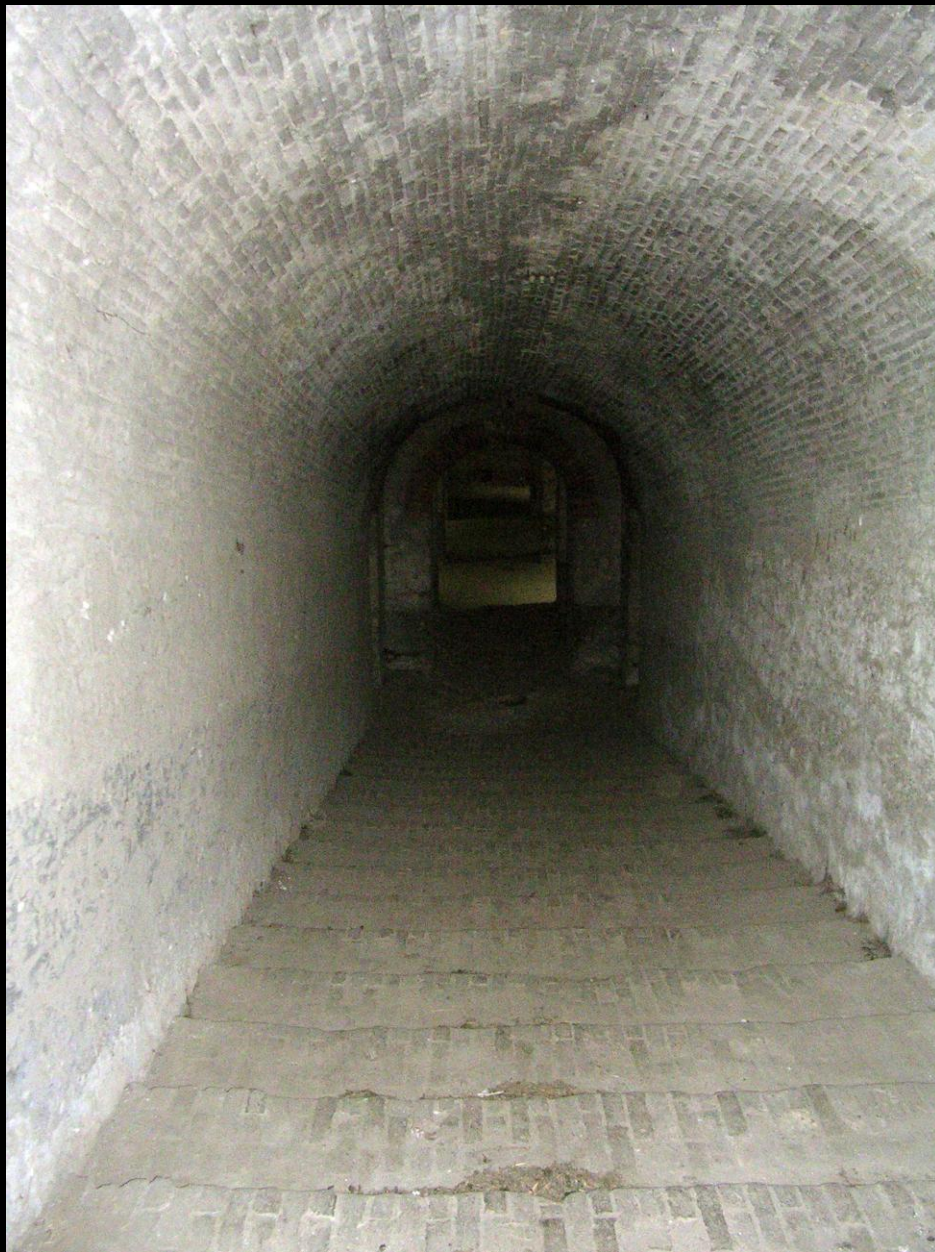
PASSAGGIO ALLE POSTAZIONI DI TIRO
