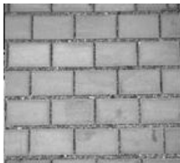
Blocchi di calcestruzzo drenante
