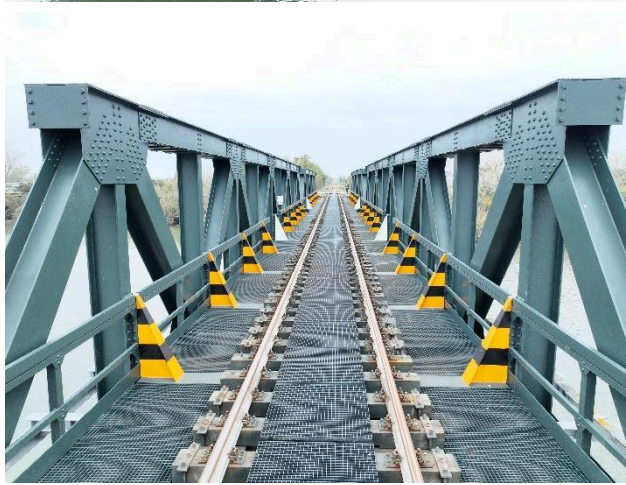
Figura 14 – rilievo con drone, ponte ferroviario, Chioggia (Venezia)
