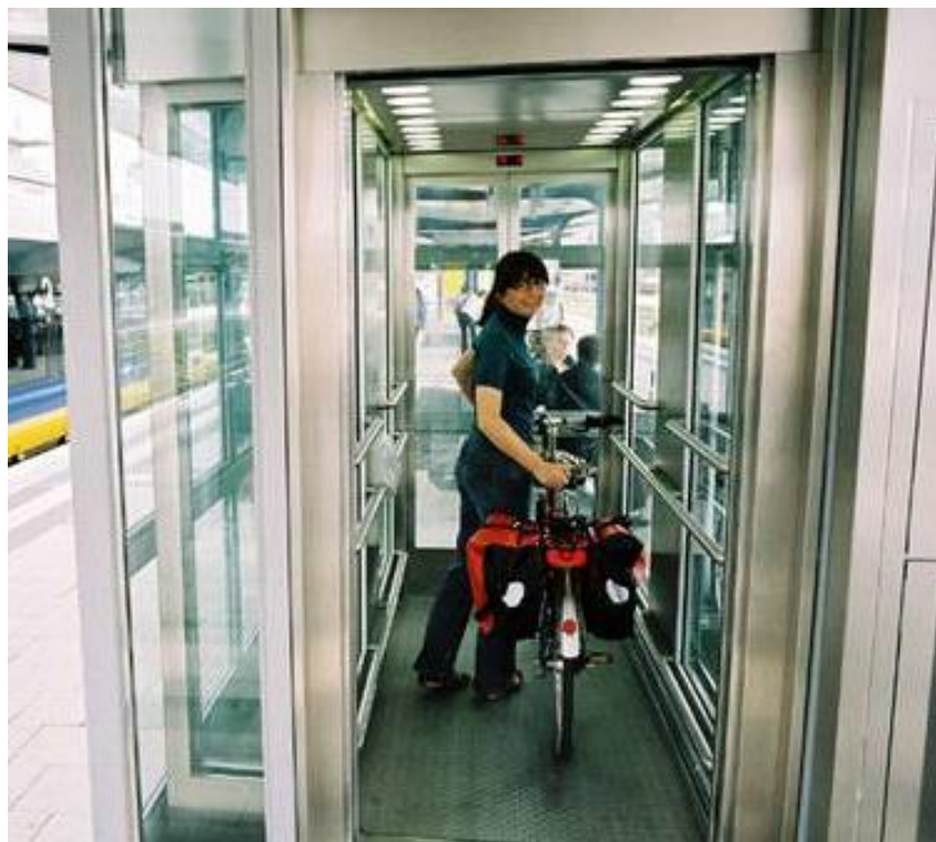
Ascensore di dimensioni adeguate, stazione DBahn di Bielefeld, Germania
