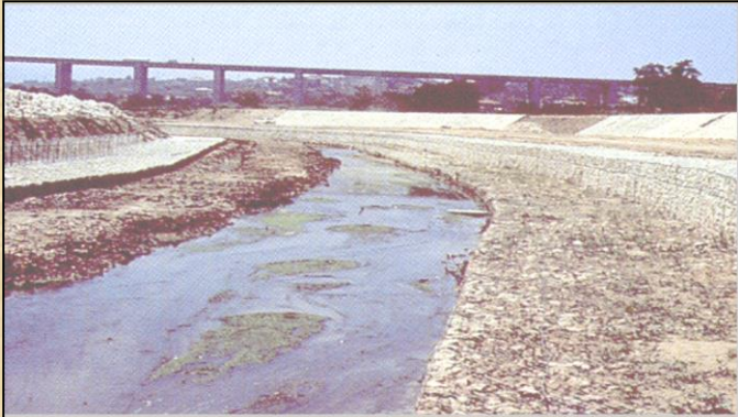
Durante la costruzione
