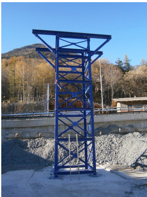
Realizzazione struttura portante per il nastro trasportatore
