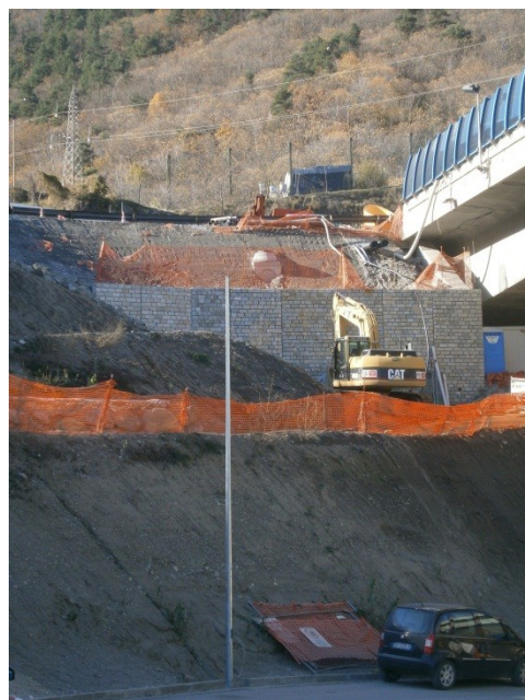
Realizzazione varco autostradale da parte di SITAF per accesso al cantiere
